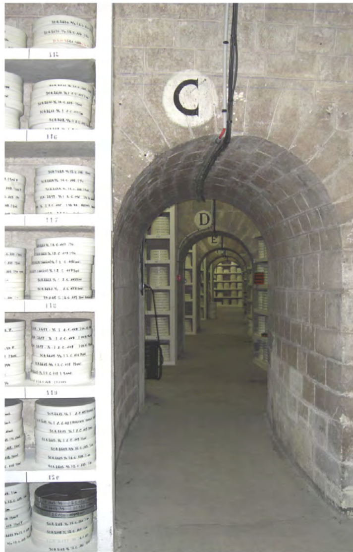
n°22, photographie de quelques unes des 18 casemates de stockage à l'ECPA-D avant 2007
