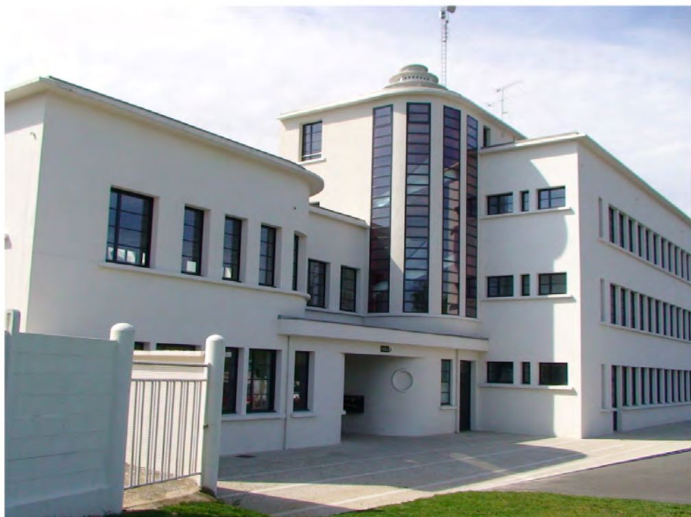
n°23, photographie de l'entrée du pôle patrimoine de Centre Images à Issoudun
