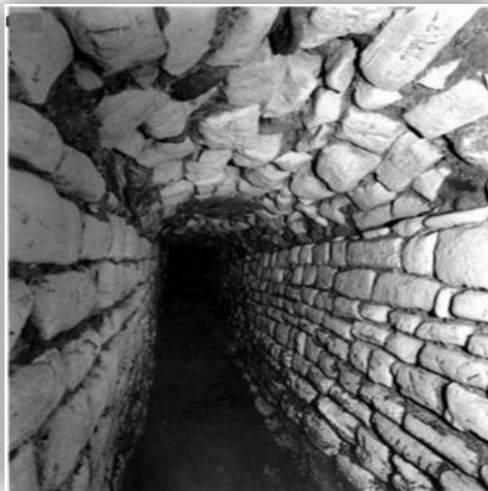
Figure 4. Égout romain (à Narbonne), d'une largeur de 0.70 m, sur 72 m de long, et une hauteur variant entre 1.30 et 1.80 m. Source : Dellong et al. , 2003
