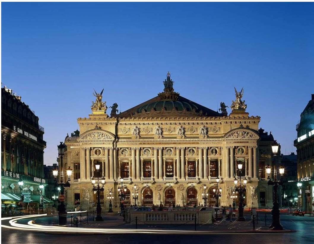
Fig. 50. Le Palais Garnier (façade) 788
