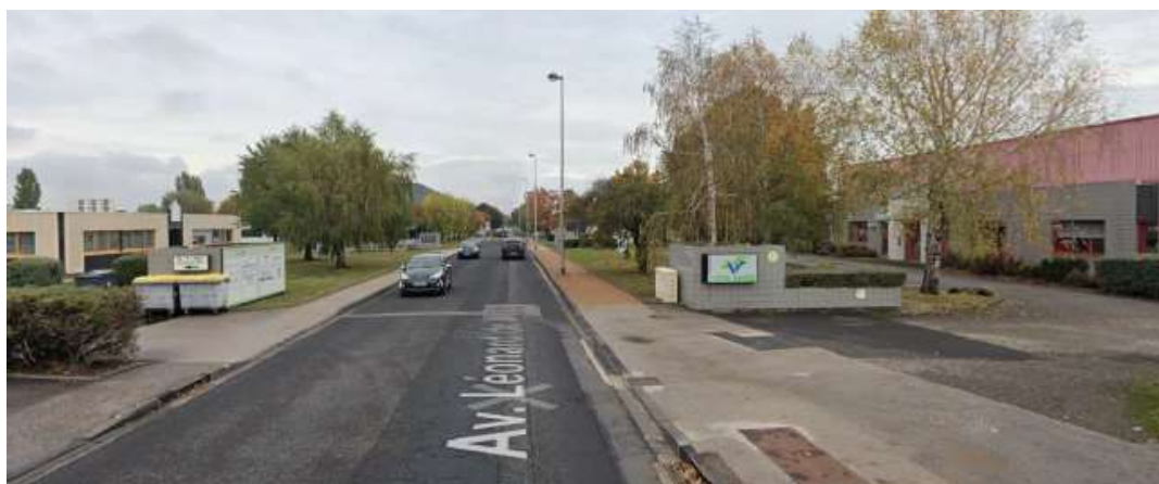
L'avenue Ernest Cristal jouant le rôle de véritable limite visuelle et physique entre le nord et le sud du parc technologique
