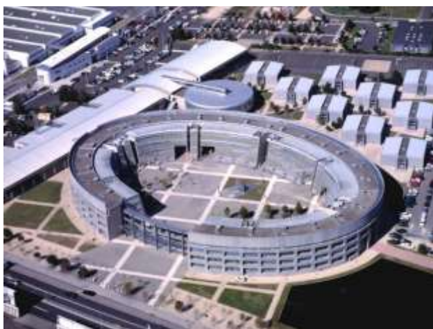
Fig. 57 – Le lycée Lafayette reconnaissable à son architecture circulaire est le bâtiment emblématique du parc technologique La Pardieu
