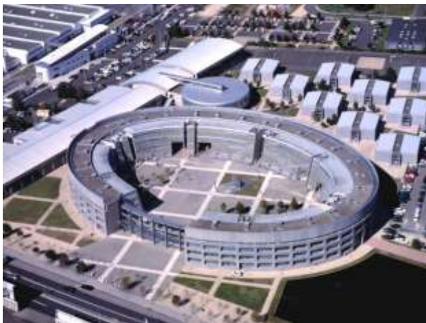
Fig. 57 – Le lycée Lafayette reconnaissable à son architecture circulaire est le bâtiment emblématique du parc technologique La Pardieu
