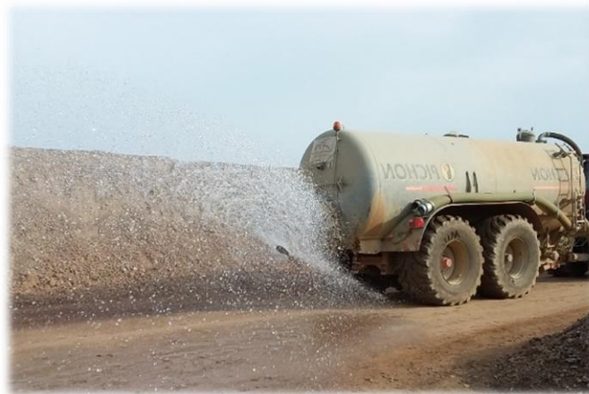
Figure 1-7 : Arrosage d'une piste de circulation sur un chantier (photo : Ouardia Sediki)
