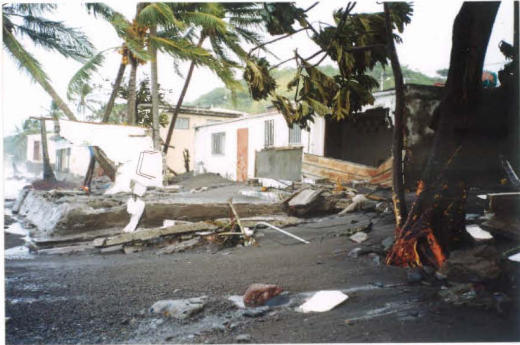
Photographie 19 :Les effets de la houle cyclonique au Prêcheur (Nord Ouest de la Martinique). Une cinquantaine de maisons construites sur la plage ont été détruites. La plage a reculée de plus de quarante mètres depuis 1950. M .Desse, 1999.
