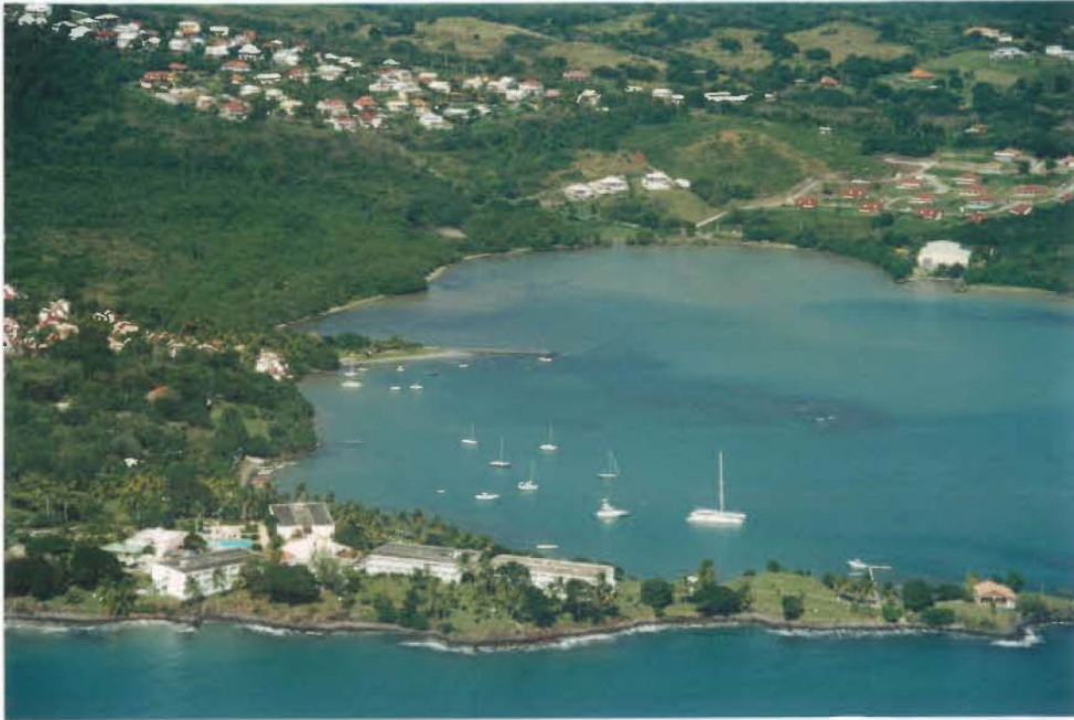
Photographie 27 : La baie de Marigot à proximité de la plage du Diamant, montre les différentes formes d'agressions possibles. Au premier plan, le Novotel, qui date de la fin des années 1970, offre une première agression visuelle, complétée par les lotissements qui grignotent les pentes. La décharge d'ordures pollue ces eaux tranquilles. La baie abritée, accueille aussi des voiliers sur mouillage. Tout ceci tend à fragiliser les récifs coralliens et les liserés de mangrove. M Desse, 2001.
