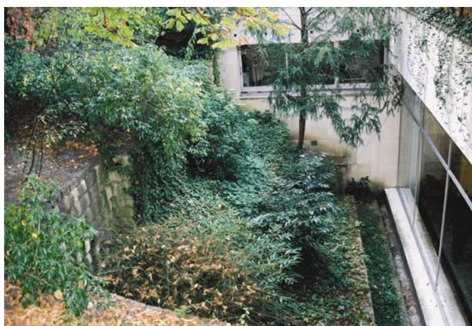
Dans le jardin de l'Hôtel de la Région d'Île-de-France, à Paris, une cour anglaise très plantée a été aménagée pour éclairer une salle en sous-sol.
