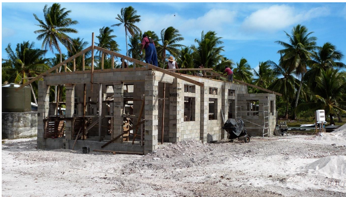
Figure 41 - Chantier de reconstruction de l'Église du septième jour à Tauhunu - Manihiki (photo D. Glory, 2018)
