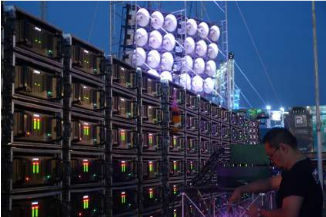
Figure 20 Un muret d'amplificateurs dans le cadre de la pratique des cinémas de plein air (cf. Chap. V) avec une « guirlande de fleurs » ( phuang malay , พวงมาลัย) suspendue en haut au centre de la photographie, temple Na Khok, 25/01/2018.
