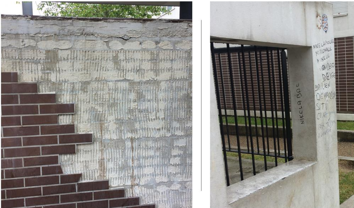
Figure 34. Des exemples de dégradations : un mur dégradé (parements décollés) et un mur tagué. Source : A. Mille, avril 2017 (bailleur enquêté, Yvelines).
