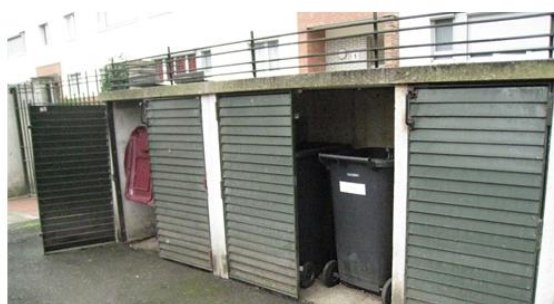
Figure 37. Les conteneurs à poubelles : dégradations et problèmes de sous-dimensionnement. Source : A. Mille, avril 2017 (bailleur enquêté, Yvelines et Essonne).
