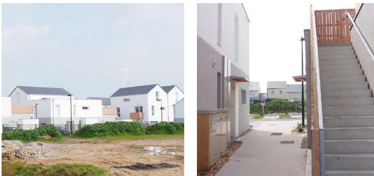
Figure 92. Les jardins du bois de la cour à Saint-Reine-de-Bretagne - SILENE (source : auteur)
