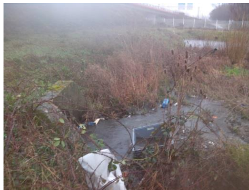
Figure 108 : Zone d'entrée du bassin de rétention-infiltration des eaux de ruissellement du pont de Cheviré
