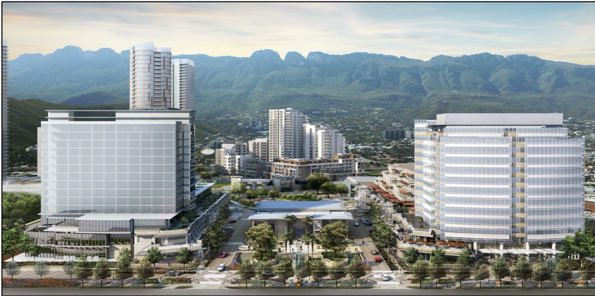
PHOTOGRAPHIE 4. Vue d'ensemble du complexe urbain multifonctionnel Arboleda
