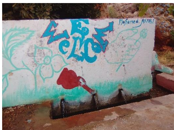
Photo 2 : aménagement de la source
