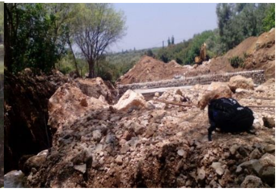
Photo 6 : travaux de protection de la source (Gaffer)
