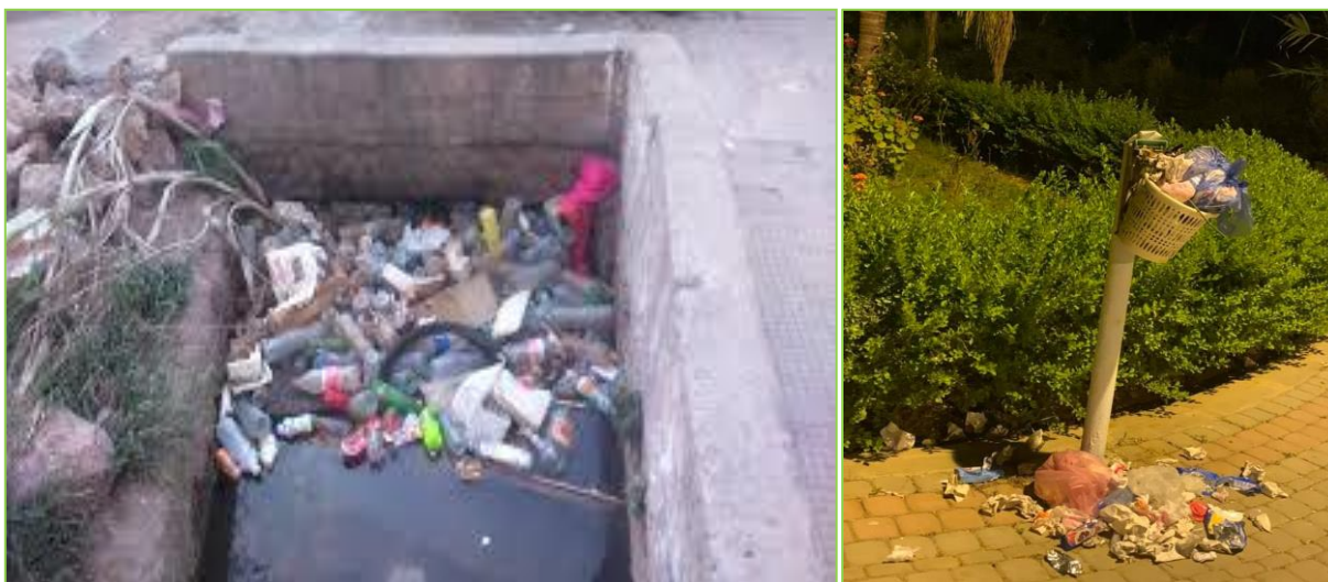
Photo 81: Déchets solides laissés, Ain Asserdoune (2016) ; Photo 82: Déchets solides à Ain Tamda (Ait Omar, 2019)
