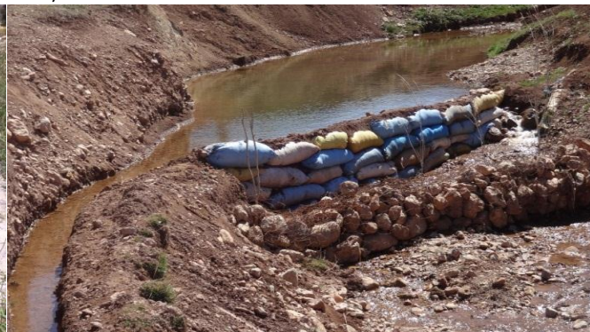
Photo 6 : Technique d'Agoug (un petit barrage
