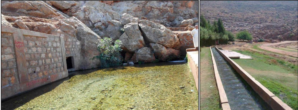
Photo 2 : les murs protégeant la source Photo 2 : Saguia acheminant l'eau aux champs agricoles
