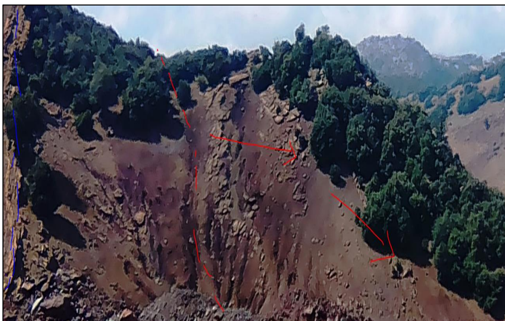
Photo 1 : glissement de terrain d'Idemrane
