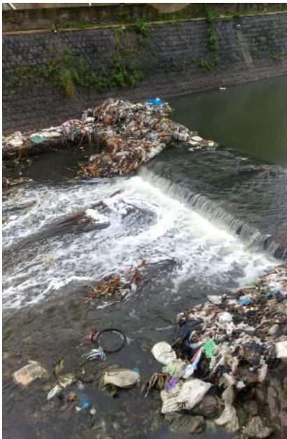
Photographie 4 : Le barrage partiellement cassé par les communautés de Limalasan en saison des pluies (auteure, 2017)
