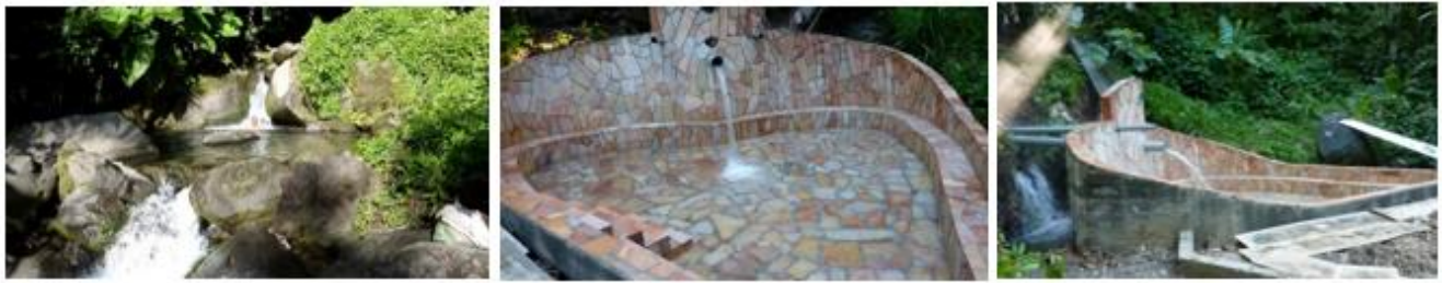
Figure 26 : Bassin en libre accès dit "Bain des Amours " à Capès. Commune de Gourbeyre (clichés de l'auteur)
