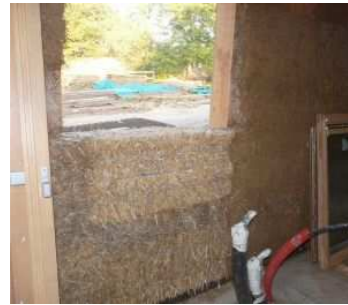
Isolation avec ballots de paille
