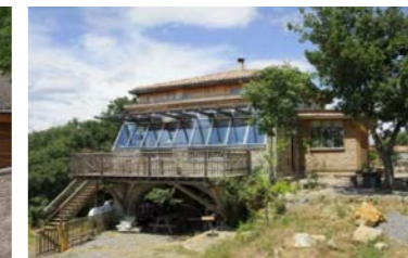
Le Mas, bâtiment réhabilité © Le Hameau des Buis
