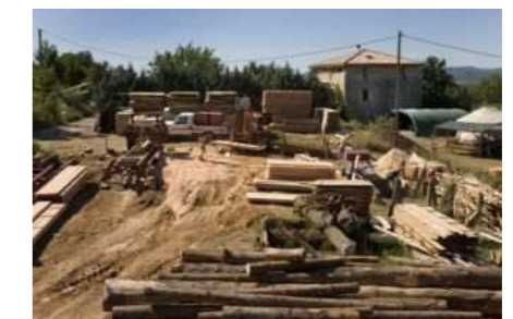
Vue sur le poste de sciage à l'entrée du Hameau. Le bois est une ressource locale qui vient du département
