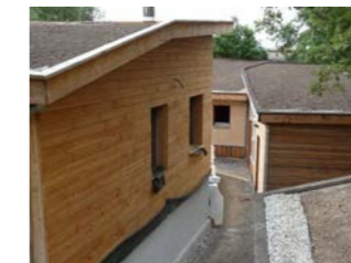
Vue des logements, toitures végétalisées bardage bois © Le Hameau des Buis
