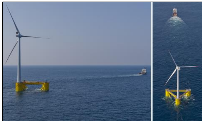
Figure 10 : Première éolienne flottante au Portugal – projet Windfloat (2012)
