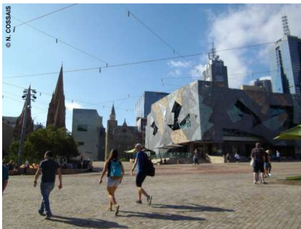
Figure 18 : Federation Square, Melbourne, Australie. Les eaux pluviales collectées sur cette place sont réutilisées pour les chasses d'eau de l'Office du tourisme situé à proximité. Photographie du 4 mars 2017.
