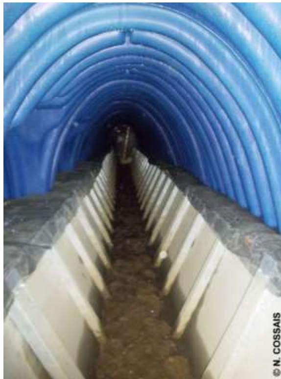
Figure 13 : Bassin enterré utilisant des structures préfabriquées en polyéthylène haute densité (PEHD), type Eluvio®. Photographie du 5 mai 2015.
