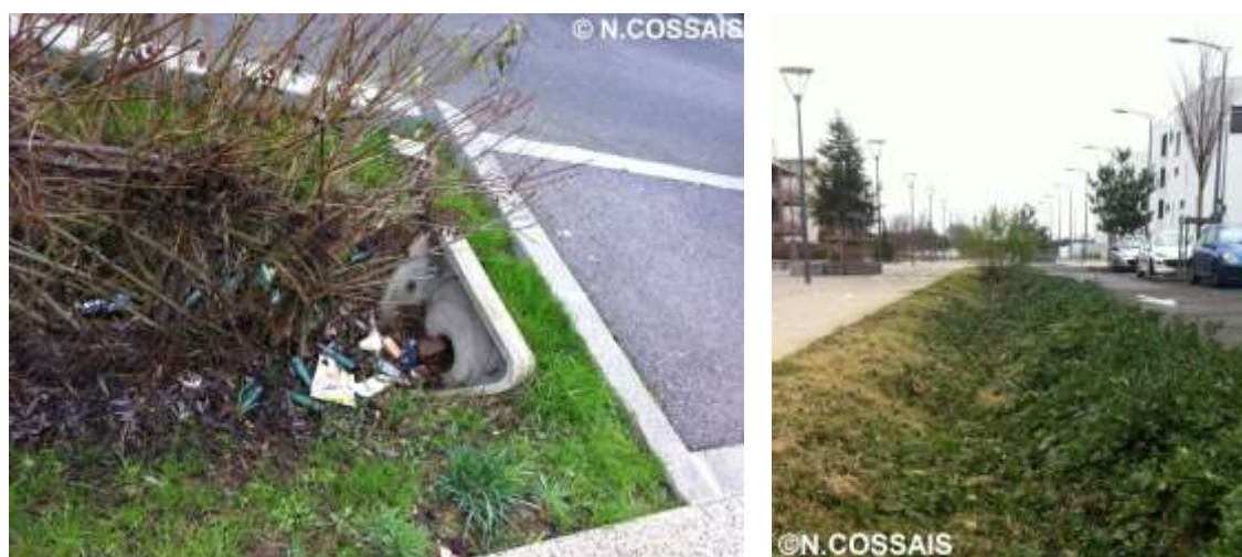
Figure 109 : À gauche, noue avec arbustes retenant les déchets. À droite, noue sans arbuste, facilitant la collecte des déchets et la fauche. Photographies du 27 janvier 2016.
