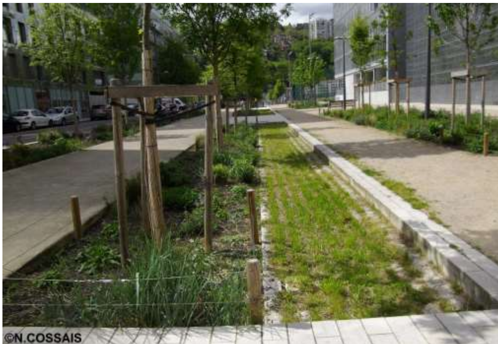
Figure 108 : Noue construite à côté d'un revêtement sablé. Le sable tend à s'accumuler dans la noue. Photographie du 3 mai 2016.
