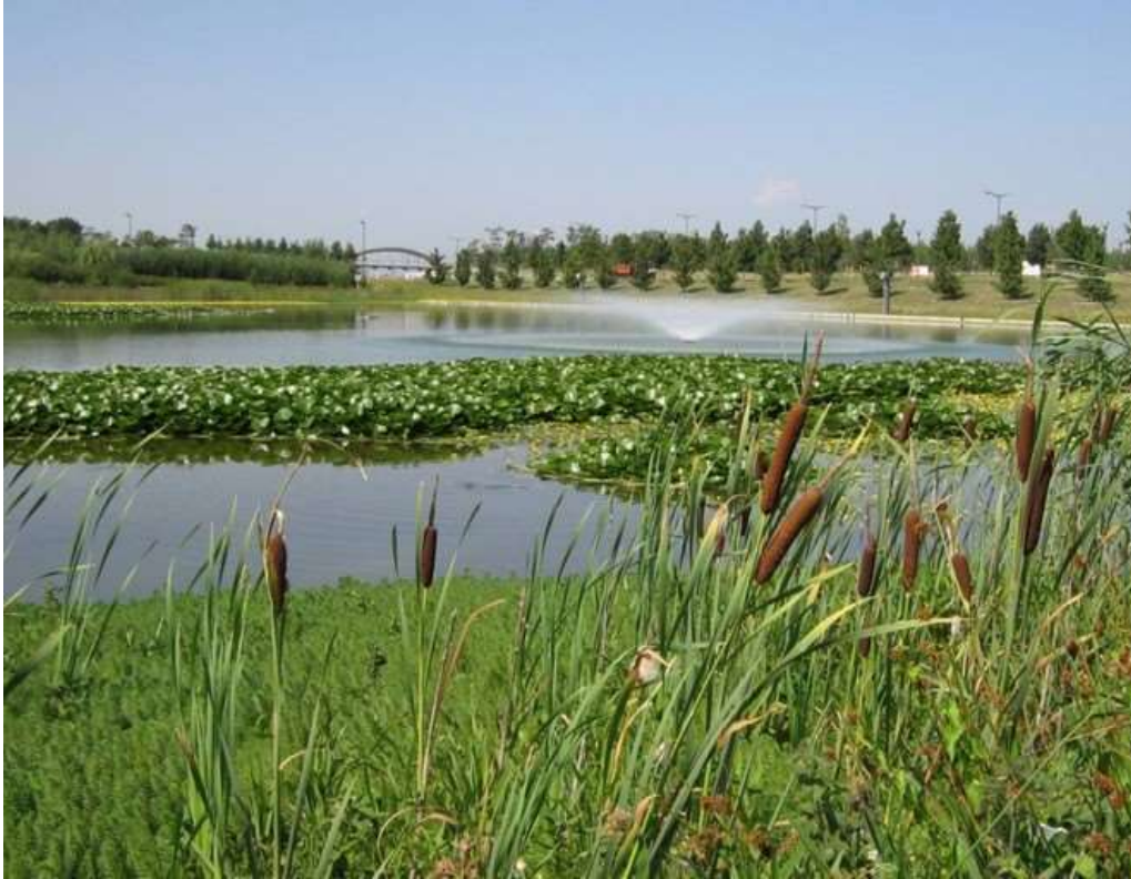
Figure 22 : Bassin de rétention des eaux pluviales sur le site de la Porte des Alpes à Saint-Priest, en périphérie de Lyon. Source : Grand Lyon.
