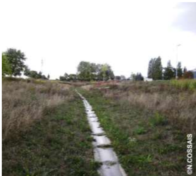
Figure 86 : Noue végétalisée rue Baden Powell à Strasbourg. Photographie du 14 septembre 2015
