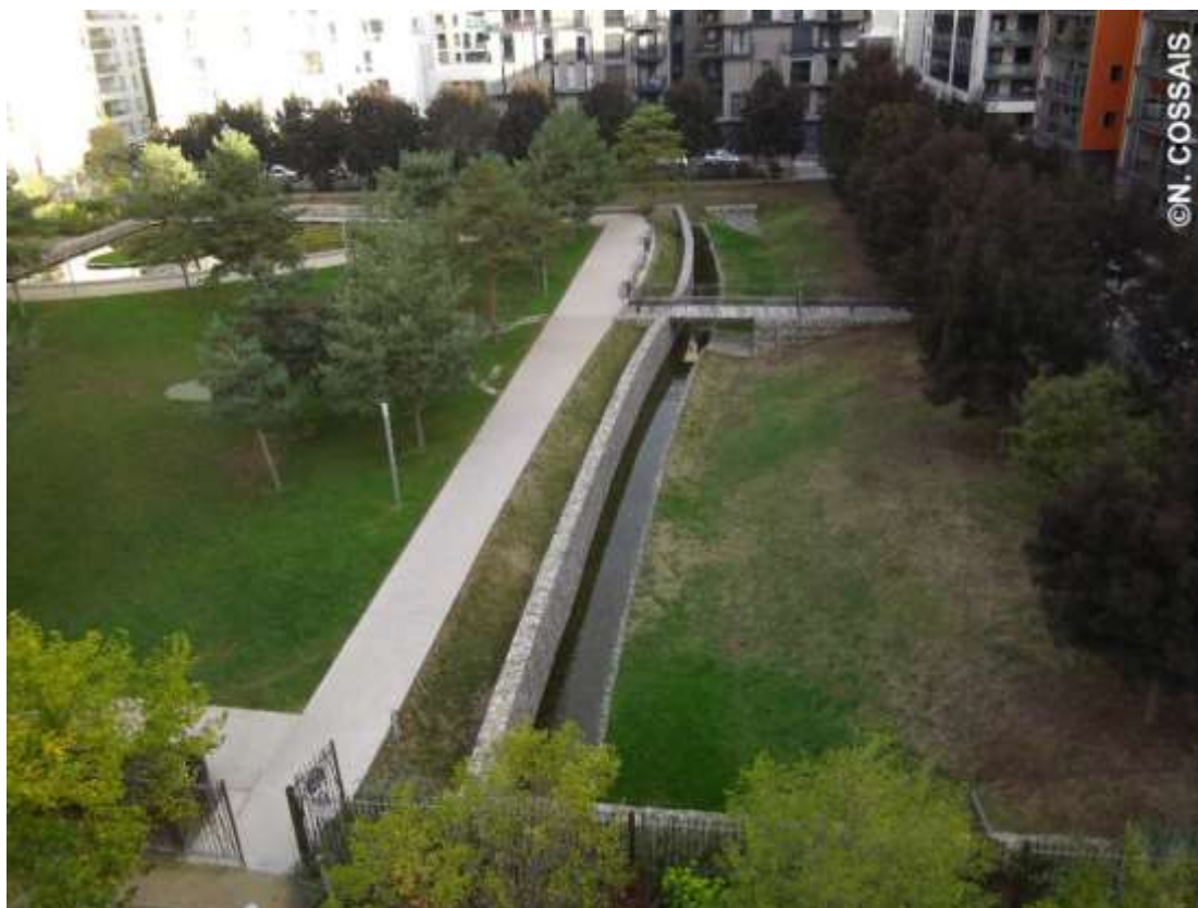
Figure 39 : Dispositifs de gestion des eaux pluviales du parc Jacob Kaplan dans le 3 ème arrondissement de Lyon. Vue aérienne sur la douve, octobre 2016.
