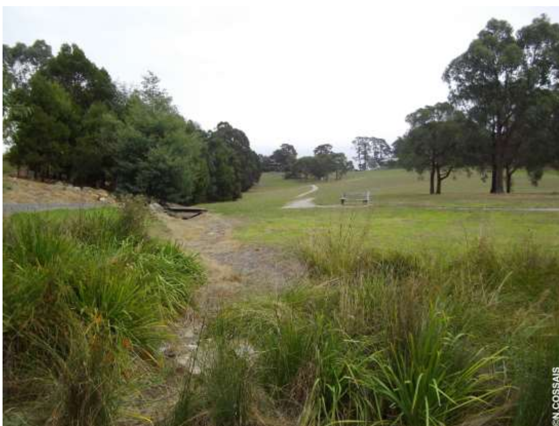
Figure 99 : Système de collecte des eaux pluviales en vue de leur réutilisation pour l'arrosage des terrains de sports d'un complexe sportif situé au niveau de la colline de Mount Evelyn sur la commune de Yarra Ranges. Photographie du 16 mars 2017.
