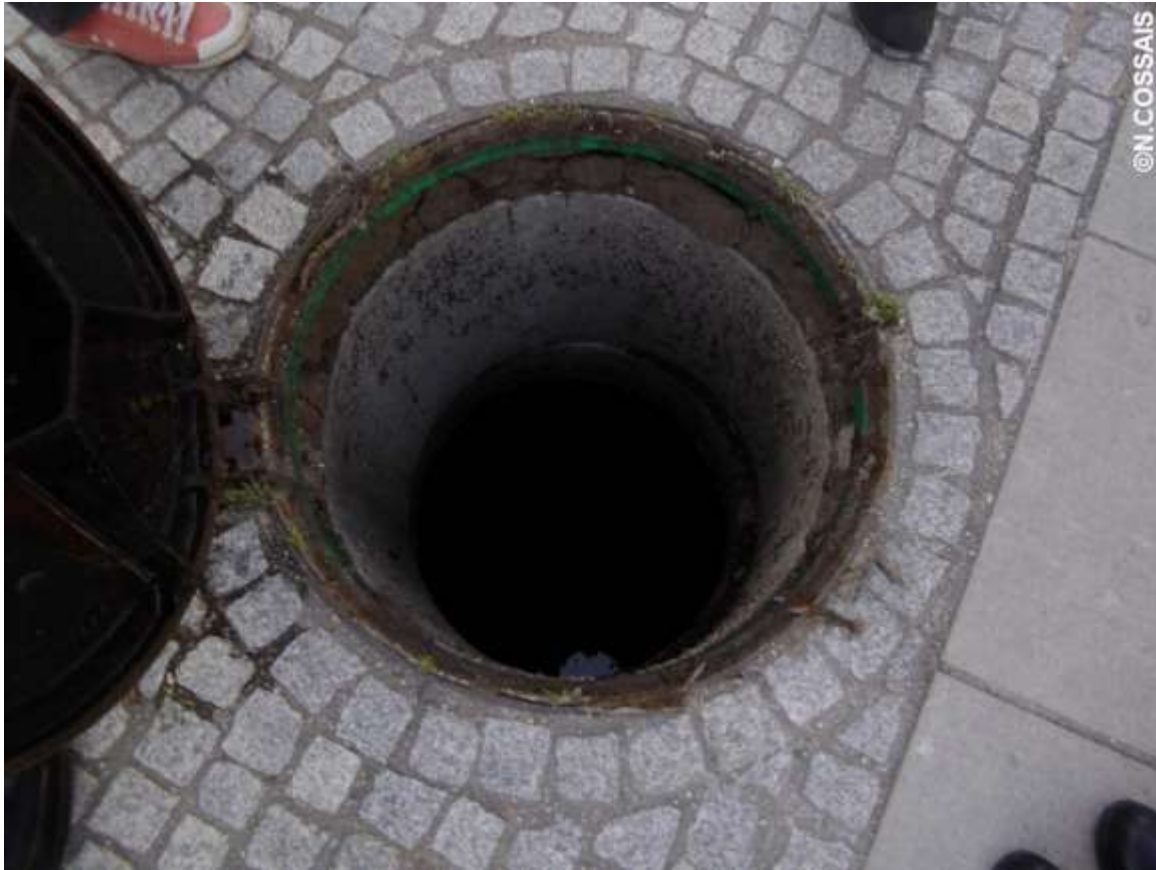
Figure 11 : Puits d'infiltration sur le parvis de l'ENS à Lyon. Photographie du 13 mars 2015.
