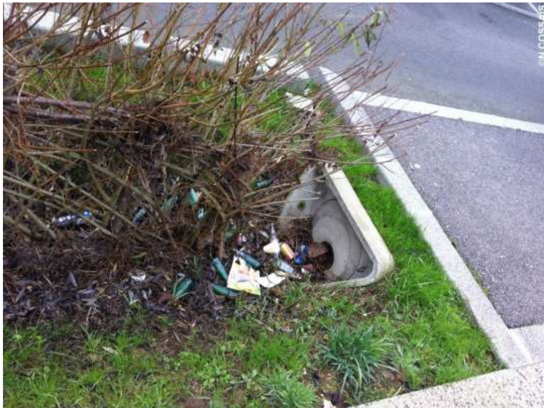
Figure 33 : Déchets dans une noue végétalisée à Vénissieux, en périphérie de Lyon. Photographie du 27 janvier 2016.
