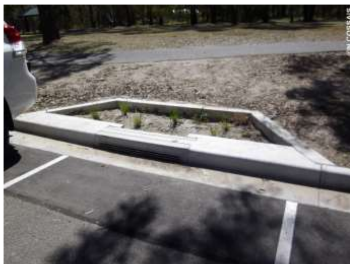
Figure 92 : Filtres plantés, Manningham. Photographie du 9 mars 2017.
