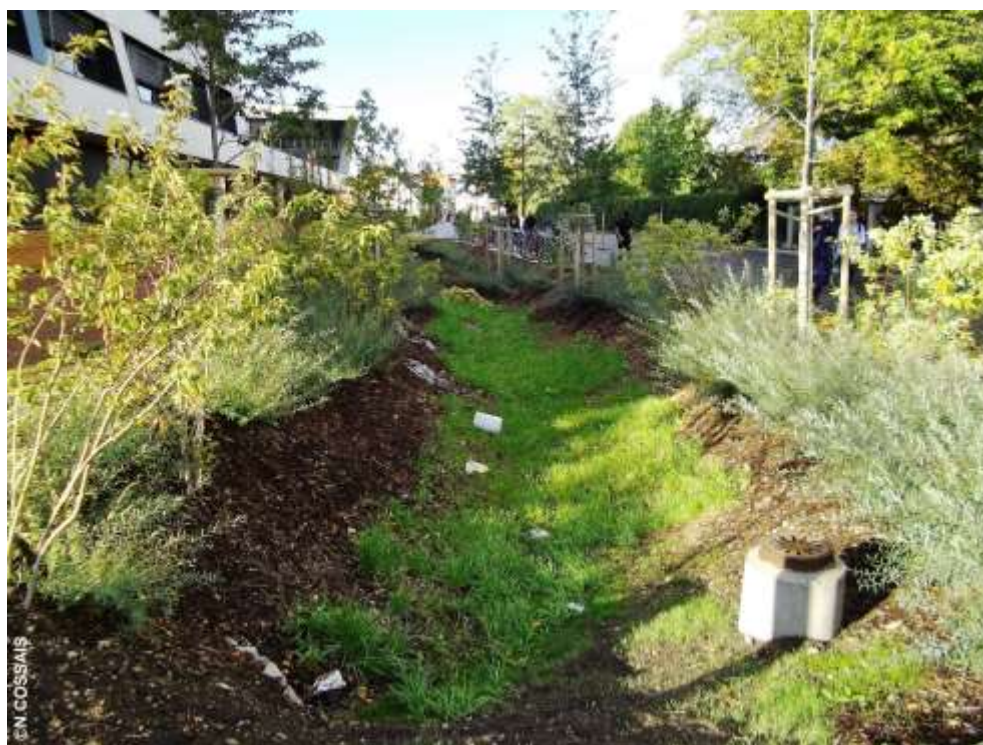
Figure 31 : Déchets dans une noue, Ecole européenne de la Robertsau à Strasbourg. Photographie du 14 septembre 2015.
