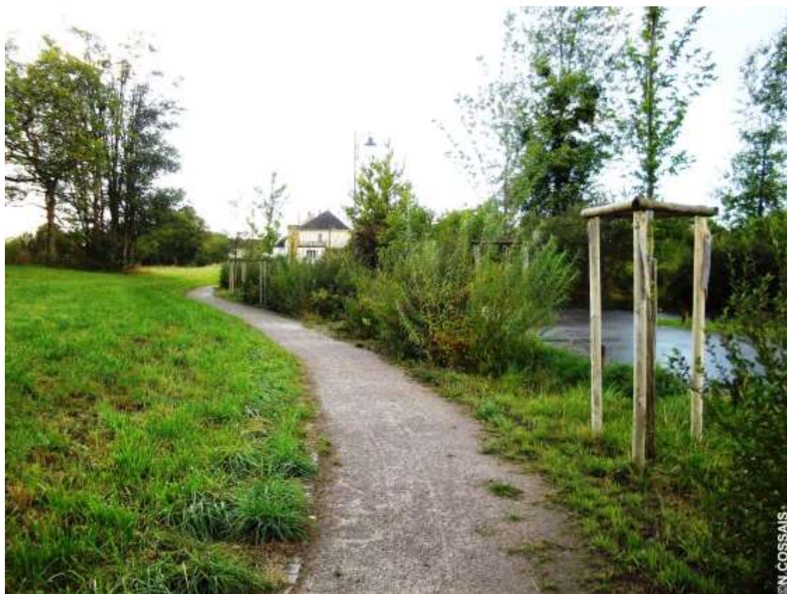
Figure 88 : Noue végétalisée rue de la Roue à Strasbourg. Photographie du 14 septembre 2015.
