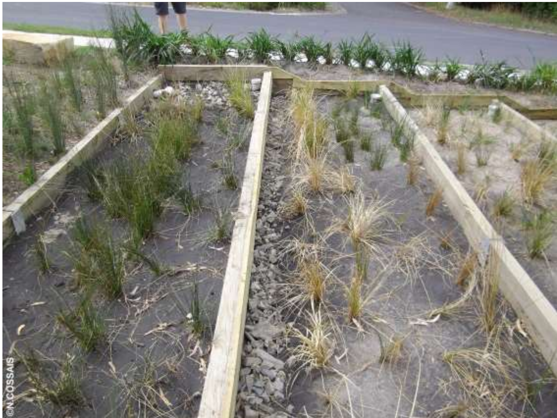
Figure 37 : Dépôt de sédiments en surface d'un jardin de pluie près de Melbourne, Australie. Photographie du 16 mars 2017.
