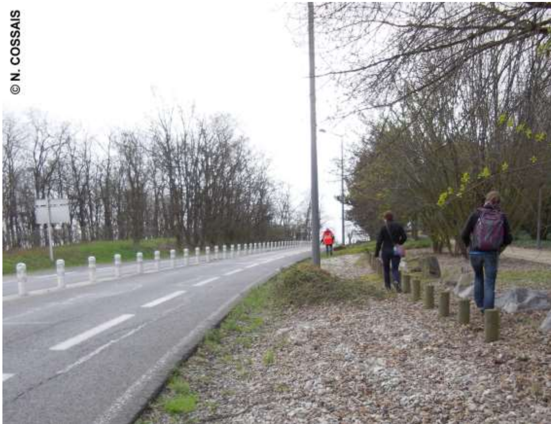
Figure 10 : Tranchée d'infiltration. Parc technologique de la Porte des Alpes à Saint-Priest. Photographie du 27 mars 2015.
