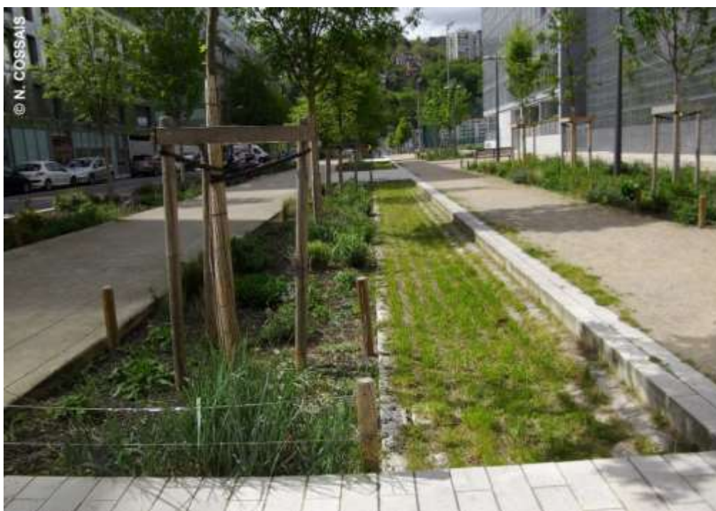
Figure 9 : Noue semi-minéralisée. Photographie du 3 mai 2016.
