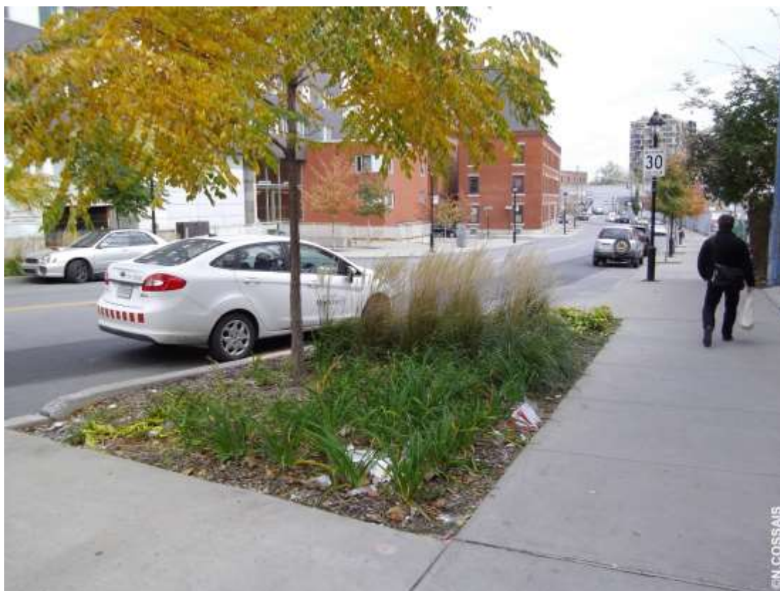
Figure 32 : Déchets dans un jardin de pluie à Montréal, Québec. Photographie du 20 octobre 2015.
