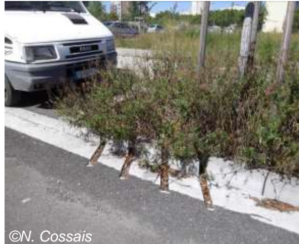
Jardin de Pluie. Aménagement suivi par la direction de l'aménagement. À gauche : vue d'ensemble. À droite : détail sur ouvertures permettant l'écoulement de l'eau.
