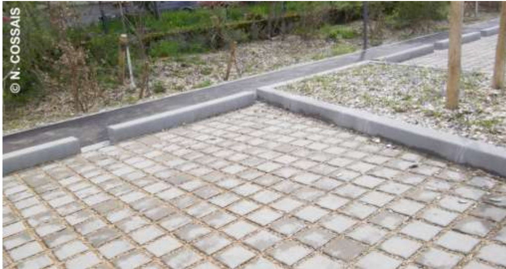
Figure 15 : Pavés à joints poreux à Vaulx-en-Velin. Photographie du 3 avril 2015.
