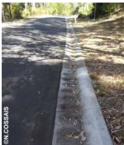
Figure 91 : Pièges à Sédiment, Manningham. Photographie du 9 mars 2017
