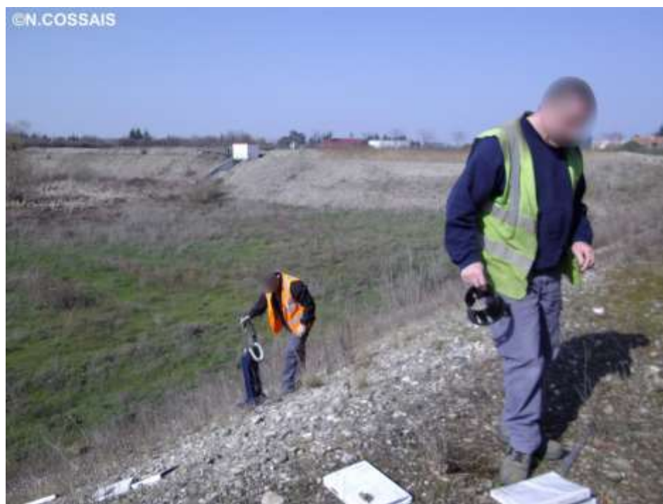
Figure 110 : Ramassage des déchets dans un bassin d'infiltration des eaux pluviales. Photographie du 14 mars 2016.
