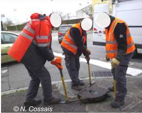
Travail en équipe. À gauche, deux égoutiers et leur chef d'équipe soulèvent un tampon. À droite, un égoutier et son chef d'équipe rangent une pige télescopique. Photographies N. Cossais. 2016
