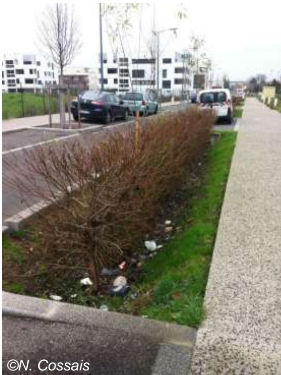
Deux noues à proximité immédiate. À gauche, noue paysagée dans laquelle les déchets s'accumulent. À droite, noue non paysagée, qui facilite l'enlèvement des déchets. Photographies N. Cossais. 2016
