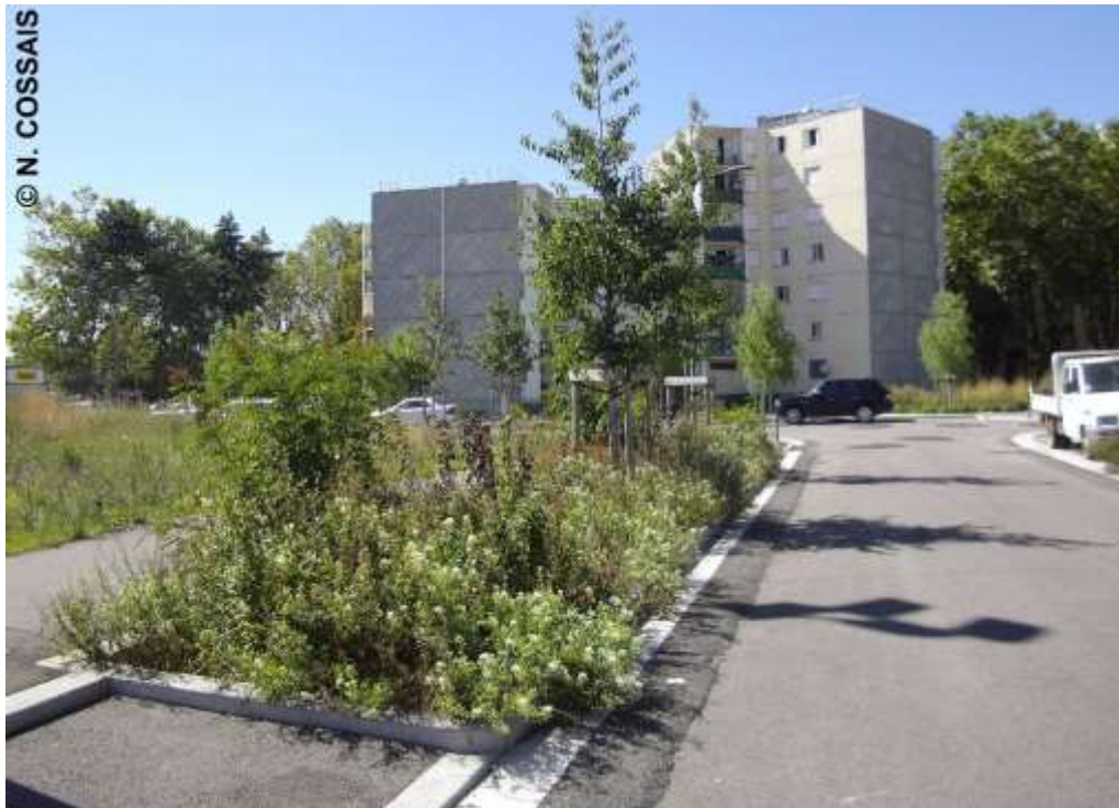
Figure 16 : Jardin de pluie. Photographie du 23 août 2016.
