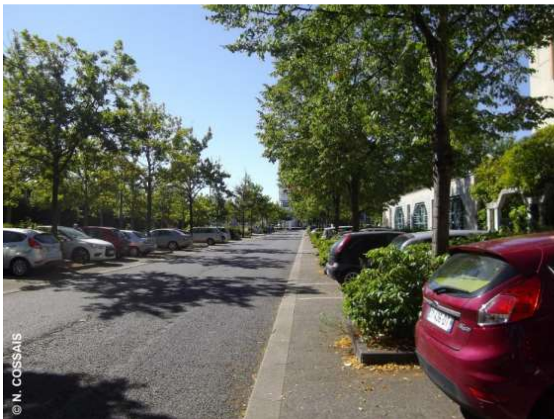
Figure 14 : Chaussée en enrobé perméable. Photographie du 25 Août 2016.
