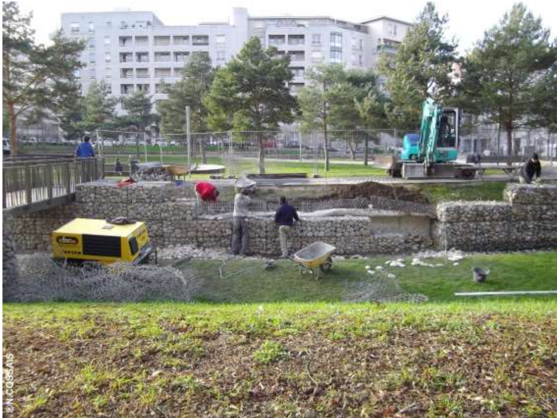
Figure 47 : Réfection du mur en gabions à la suite de dégradations par les usagers du parc. Parc Jacob Kaplan, Lyon. Photographie du 15 décembre 2015.
