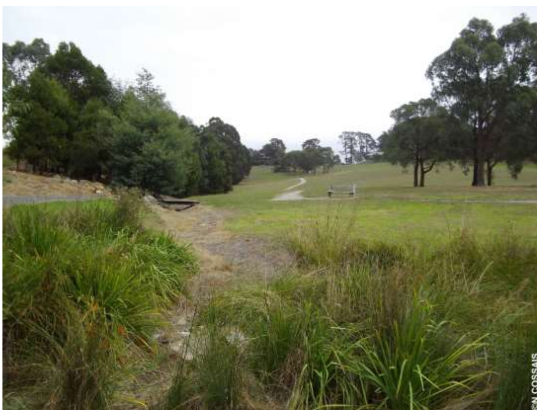
Figure 99 : Système de collecte des eaux pluviales en vue de leur réutilisation pour l'arrosage des terrains de sports d'un complexe sportif situé au niveau de la colline de Mount Evelyn sur la commune de Yarra Ranges. Photographie du 16 mars 2017.
