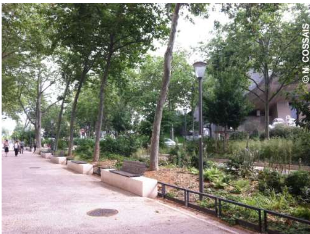
Figure 8 : Noue rue Garibaldi à Lyon. L'eau est stockée et infiltrée dans des noues plantées. Une partie de l'eau ainsi collectée est redirigée vers un bassin enterré afin d'être réutilisée pour l'arrosage des espaces verts et le nettoyage 42 des voiries. Photographie du 1 er juillet 2016.
