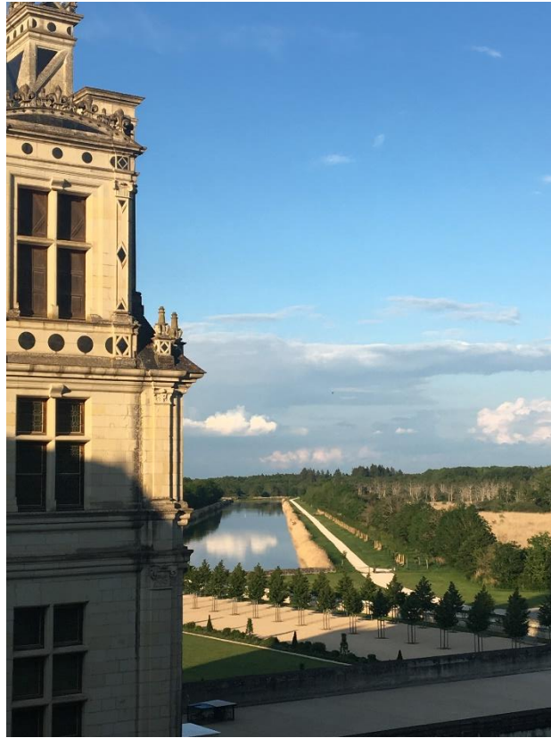
Figure 126 : Vue vers la canardière depuis le château, Chambord, 25 mai 2019
