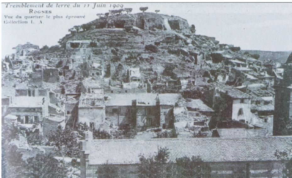
FIG. 2.1 – Dommages supportés par la commune de Rognes suite au séisme de Lambesc (11 juillet 1909,  $I_0 = IX$ ). La variabilité spatiale des dégâts dont a souffert la commune de Rognes illustre les effets de site topographiques. Les bâtiments localisés au sommet et sur les versants de la colline ont souffert de graves destructions ; ceux situés au pied du relief ont été moins touchés (source : MEDD et METLTM, 2002).
