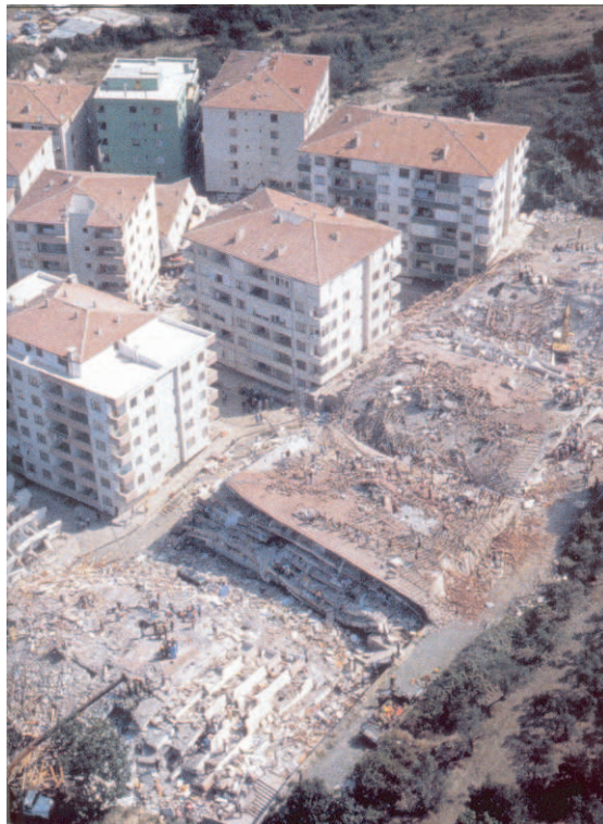
FIG. 2.4 – Variabilité spatiale des dommages suite au séisme d'Izmit (Turquie, 17 août 1999; M_W = 7.4 ). Cette variabilité illustre des effets de site géologiques et le non-respect des règles de construction élémentaires.
