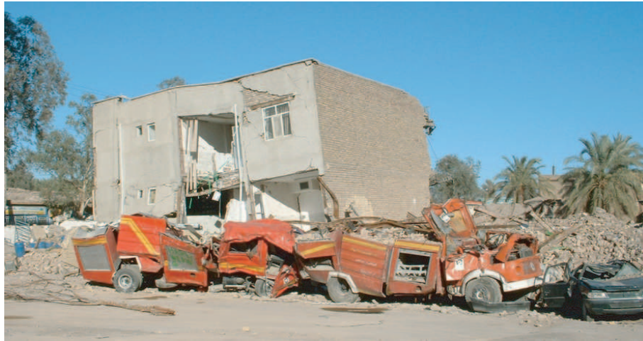
FIG. 2.17 – Camions de pompiers détruits lors du séisme de Bam (26 décembre 2003, M_W = 6.5 ; source : Th. Winter, BRGM). Si un élément clé dans la gestion d’une crise (comme une caserne de pompiers) est touché par une catastrophe, les conséquences de son incapacité de jouer son rôle seront importantes.
