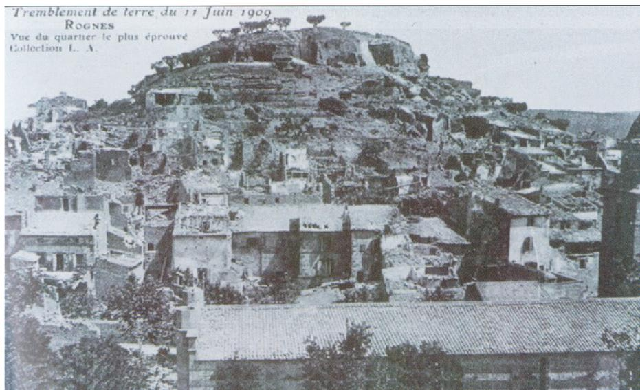
FIG. 2.1 – Dommages supportés par la commune de Rognes suite au séisme de Lambesc (11 juillet 1909,  $I_o = IX$ ). La variabilité spatiale des dégâts dont a souffert la commune de Rognes illustre les effets de site topographiques. Les bâtiments localisés au sommet et sur les versants de la colline ont souffert de graves destructions ; ceux situés au pied du relief ont été moins touchés (source : MEDD et METLTM, 2002).
