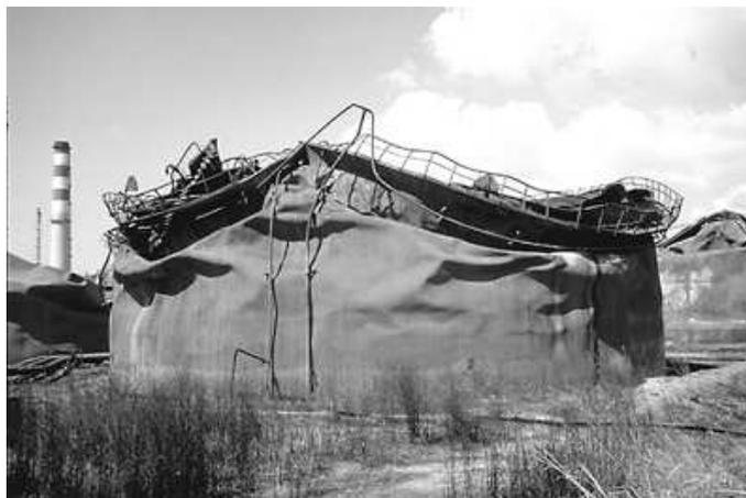
FIG. 1.5 – Dégâts causés par un incendie sur un réservoir de naphte, dans la raffinerie de Tüpras, suite au séisme d'Izmit en 1999 (source : Pacific Earthquake Engineering Research Center, Berkeley University). Cette photographie illustre un cas de réaction en chaîne entre un séisme et un accident technologique.
