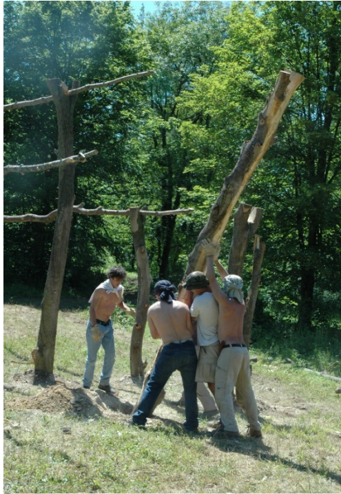
Fig. 10 : Levage d'un poteau faitier à gauche et « couloir » à droite, Nucourt (Val d'Oise), 2006.
