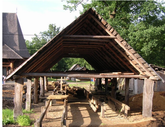
Fig. 26 : Construction à poteaux plantés avec charpente à chevrons-formant-fermes, Barsana, Roumanie.
