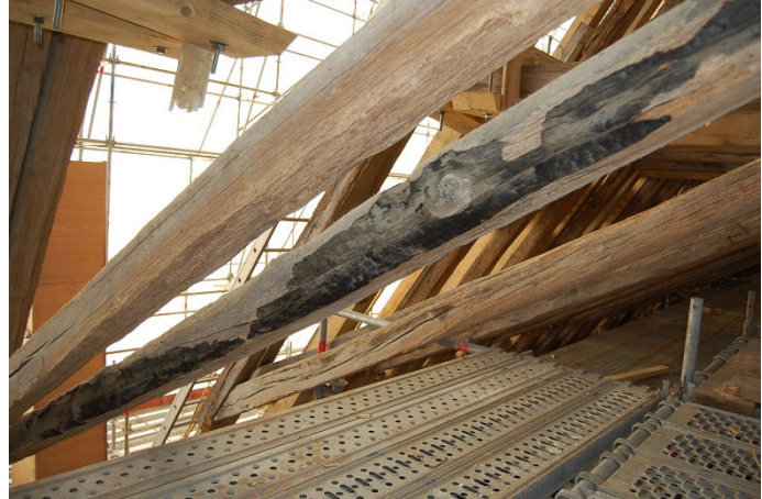
Fig. 85 : Bois carbonisé suite au traitement des grumes par le feu, charpente de la cathédrale de Bourges, 1258.
