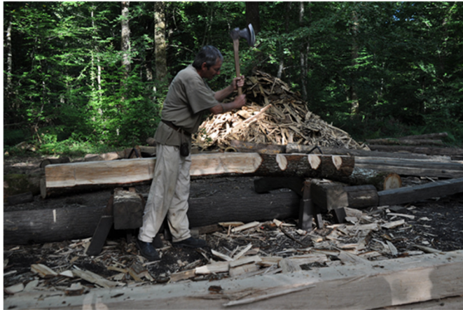
Fig. 59 : : Equarrissage à la doloire suivant les encoches d'ébauchage.
