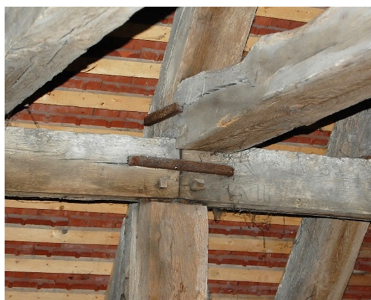
Fig. 100 : Assemblages renforcés par agrafes métalliques, collégiale Notre-Dame de Mantes-la-Jolie, 1210.
