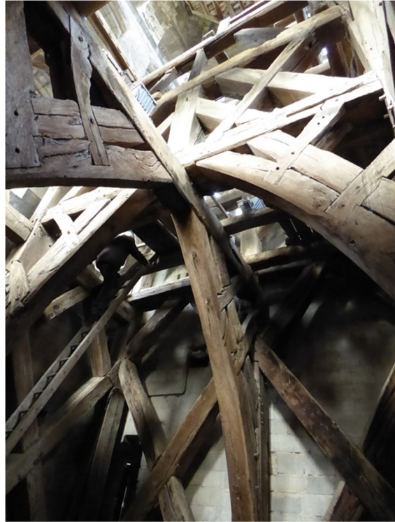
Fig. 76 : Beffroi de la tour sud, 1266.
