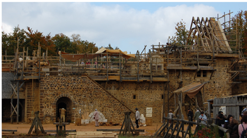
Fig. 57 : Construction du logis du château de Guédelon avec le levage de la charpente de la chambre (septembre 2008).
