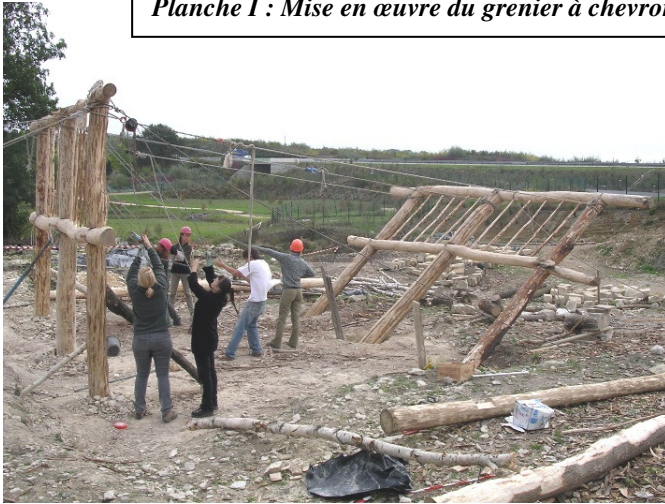
3. Levage des fermes à la perche depuis le plancher.
