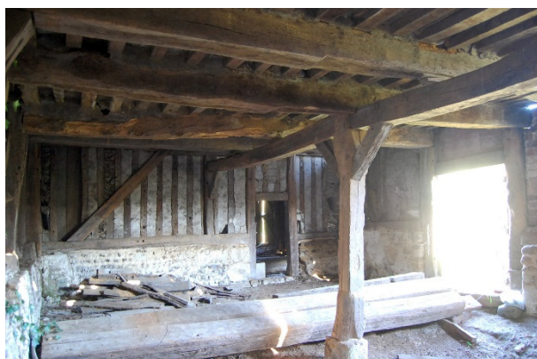
Fig. 46 : Grange-étable du XVIIe s. avec poteaux axiaux pour soutenir le plancher du fenil via une longrine. Lisieux, Calvados.
