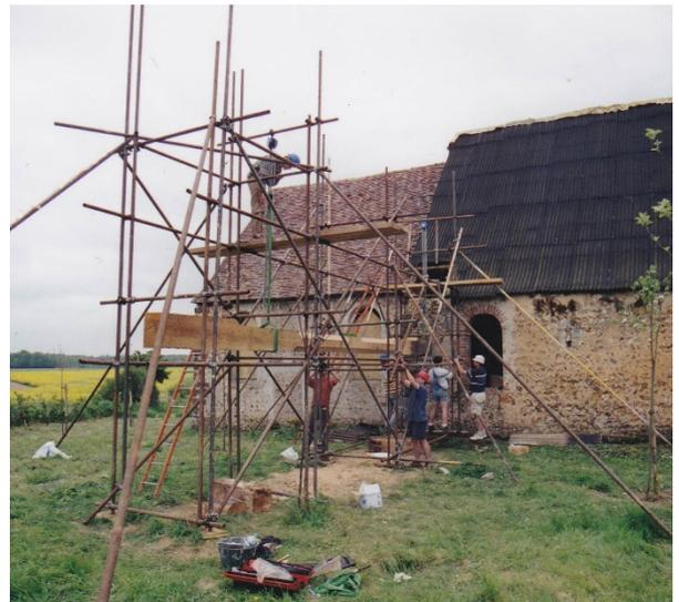
Fig. 3 : Remplacement d'un entrait, 2000
