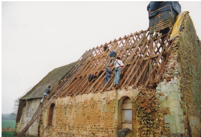
Fig. 2 : Reprise de la couverture provisoire, 1995
