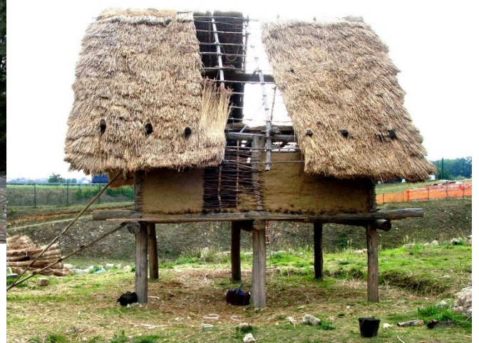
4. Pose des gerbes de roseaux et du torchis.
