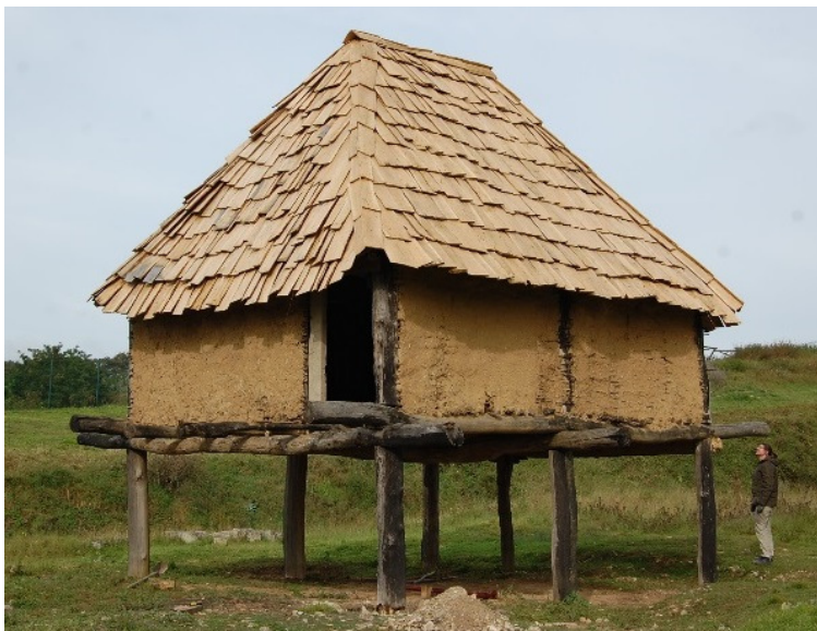
5. Grenier achevé avec sa toiture en bardeaux de chêne
