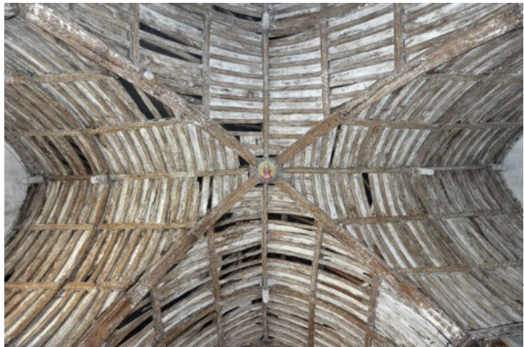
Fig. 70 : Voûte à caisson du transept de l'église de Mesnil-sous-Vienne (Eure), XVIe s., après dégagement de son enduit au plâtre du XIXe s.
