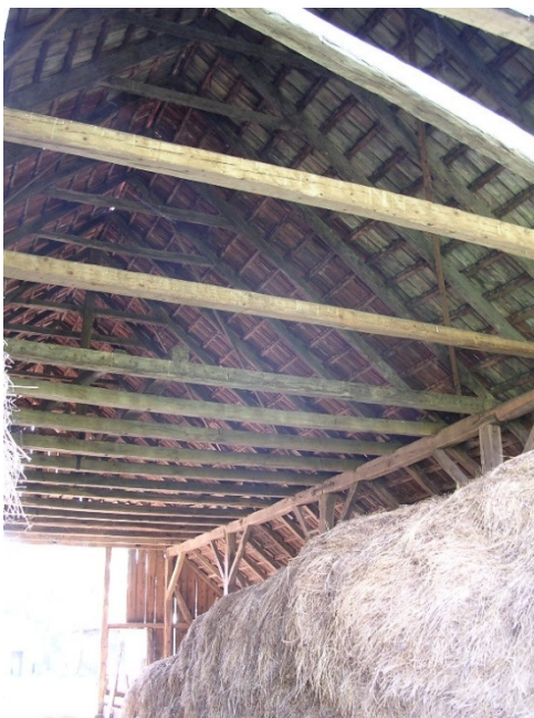
Fig. 96 : Charpente à fermes rapprochées à entrain de type roman. Grange des Maramures (Roumanie).
