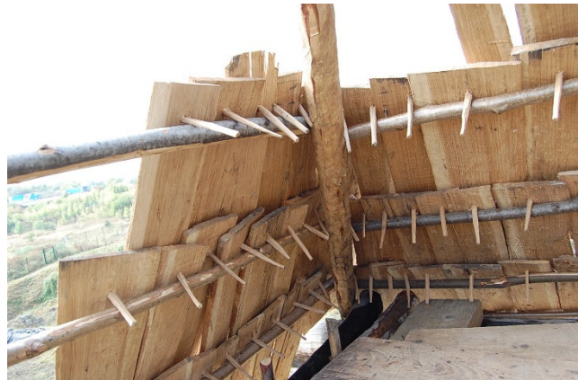
4. Fixation des bardeaux par chevillage
