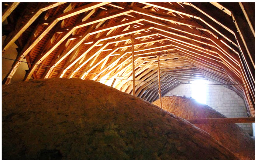
Fig. 79 : Charpente du bras sud de la cathédrale de Poitiers, avec les voûtes domeales typique du gothique angevin, 1222.
