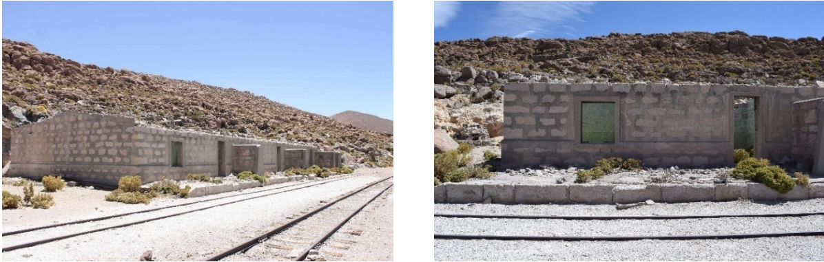
Figure 21. Station Puquios, secteur 1, vue vers le sud-ouest (gauche) et façade nord (droite).
