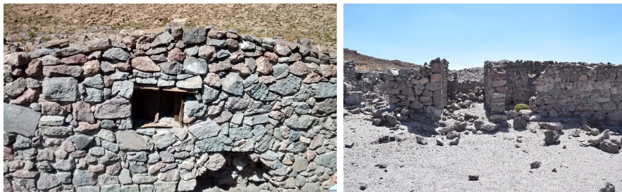
Figure 29. Puquios, secteur 4, unité f , niche (gauche) et unité h , façade est (droite).
