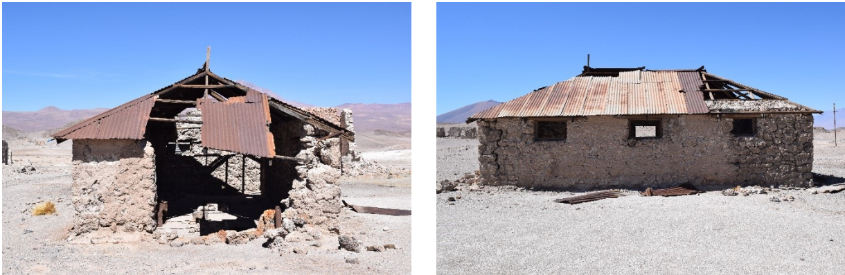
Figure 71. Buenaventura, secteur 6, structure D, façade sud-est (gauche) et façade nord-est (droite).
