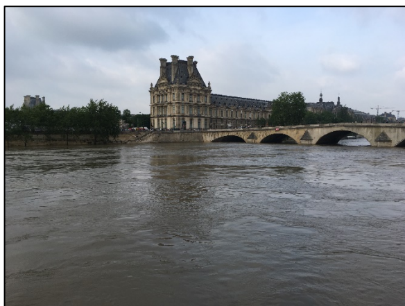
Figure 57. La Seine en crue – vue Pavillon Mollien. (Source : M-A Molinié-Andlauer, 2016)
