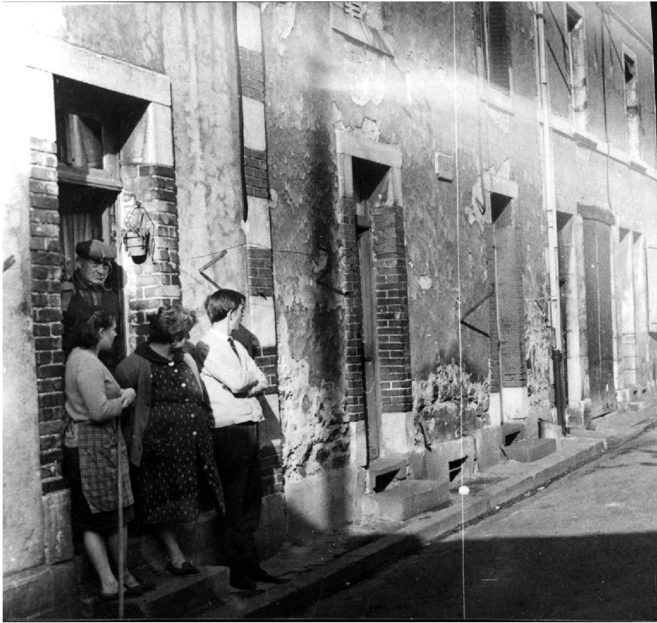
Image 23 : Immeubles de la rue Henriette Fournier (îlot de Brevelle)
