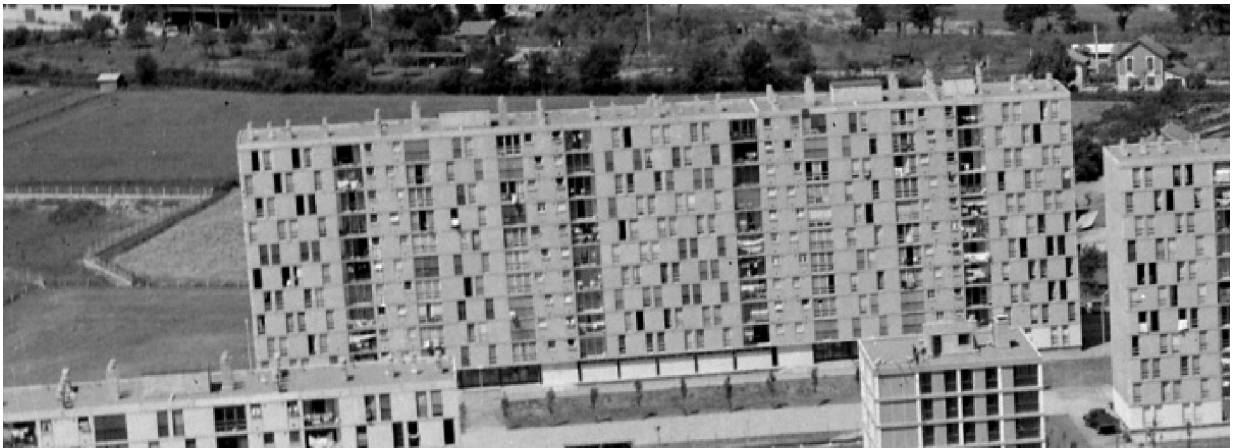
Image 45: Bâtiment C en 1963
