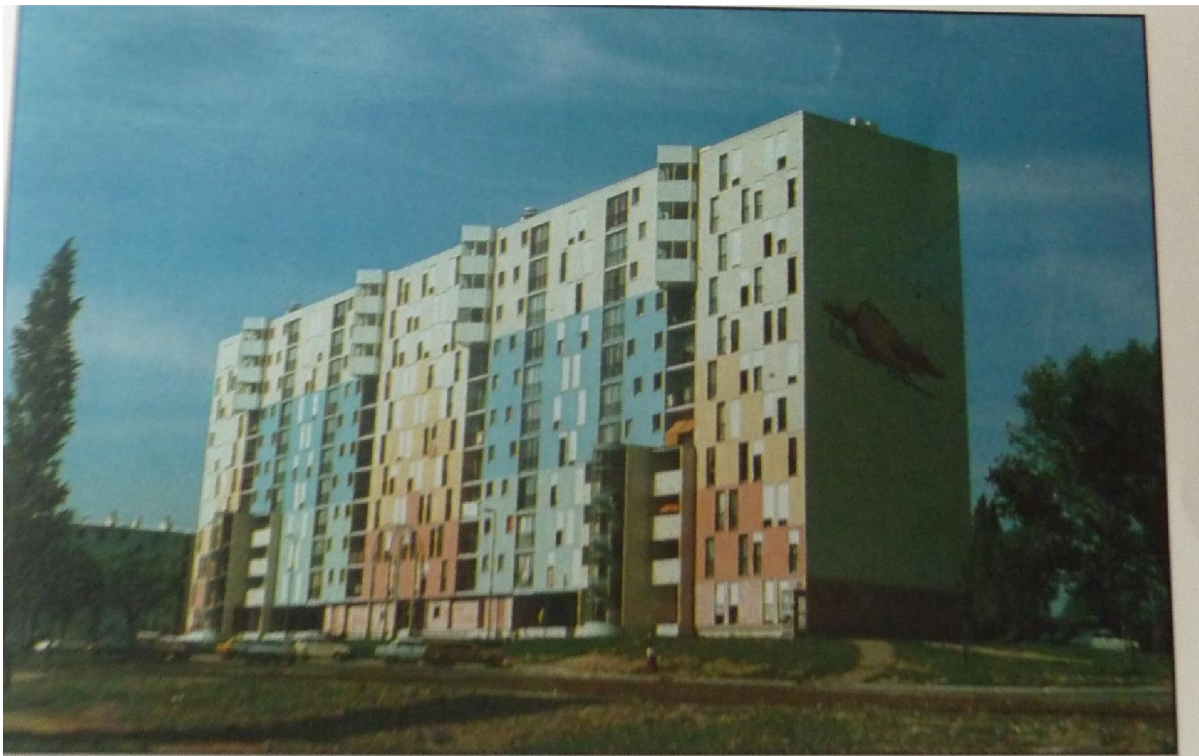
Image 46: Bâtiment C après réhabilitation en 1987
