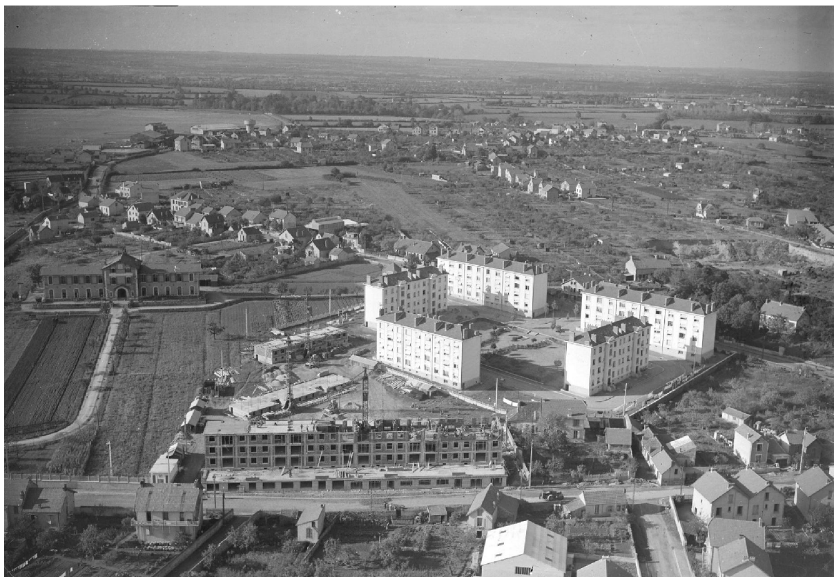
Image 10: Construction de Beaulieu (en arrière-plan cité de la rue des Droits de l'Homme)
