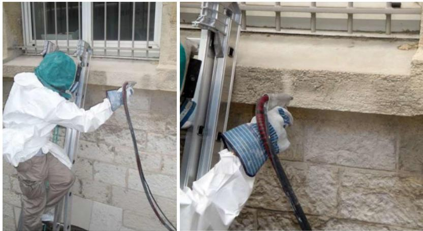
Figure 94 Sablage fin d'un appui de fenêtre (crédit photo : Philippe BROMBLET [144]).
