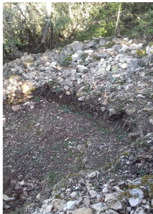
Document 111 : Pillage avec détérioration d'une courtine de l'oppidum de Manivert à Lambesc (13) (A. Dumont-Castells - 2016)
