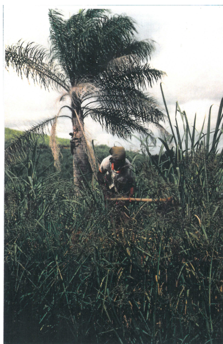
Photo 3.6 Nettoyage du terrain
