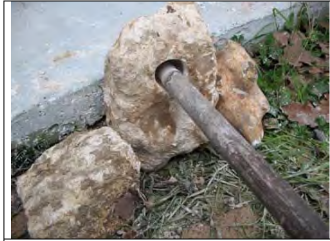
Fig. 2.162 Maintien du bloc en cours de forage
