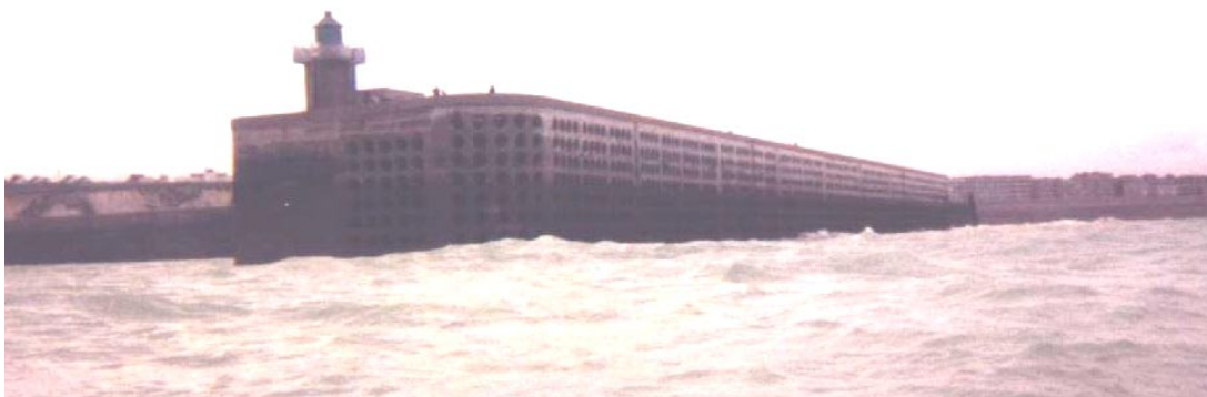
Figure 2-4 : Vue de la digue Ouest.
