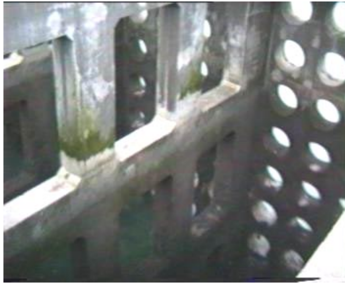
Figure 2-7 : Détail des voiles transversaux d'un caisson courant.
