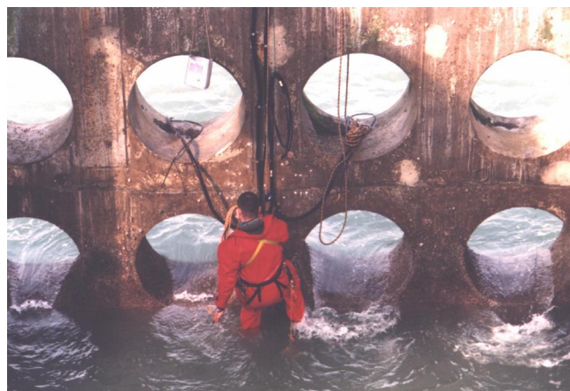
Figure 2-16 : Fixation de capteurs sur la paroi perforée.
