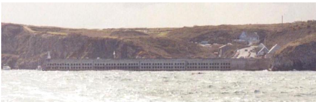
Figure 1-11 : Vue de la digue du Stiff (Ouessant).
