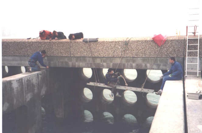
Figure 2-15 : Mise en place de câbles sous la passerelle.
