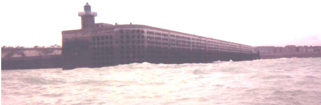
Figure 2-4 : Vue de la digue Ouest.
