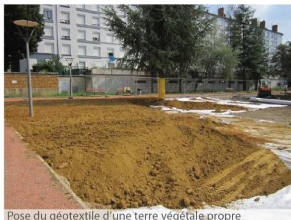
Pose du géotextile d'une terre végétale propre
