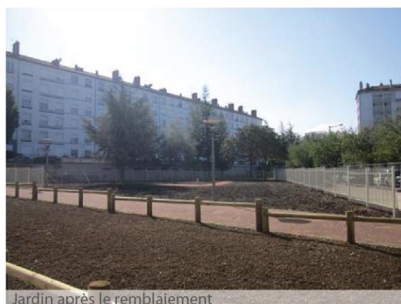
Jardin après le remblaiement
