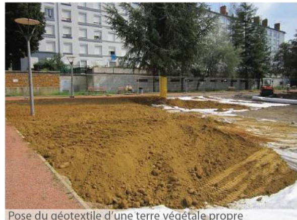
Pose du géotextile d'une terre végétale propre
