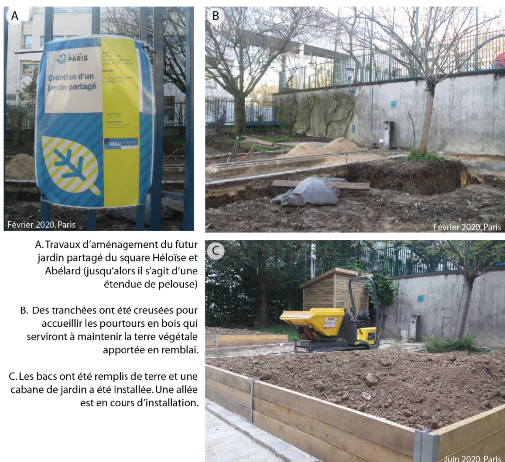
Figure 20 : L'aménagement d'un jardin partagé par les services municipaux dans le square Héloïse et Abélard (Paris 13 e )
