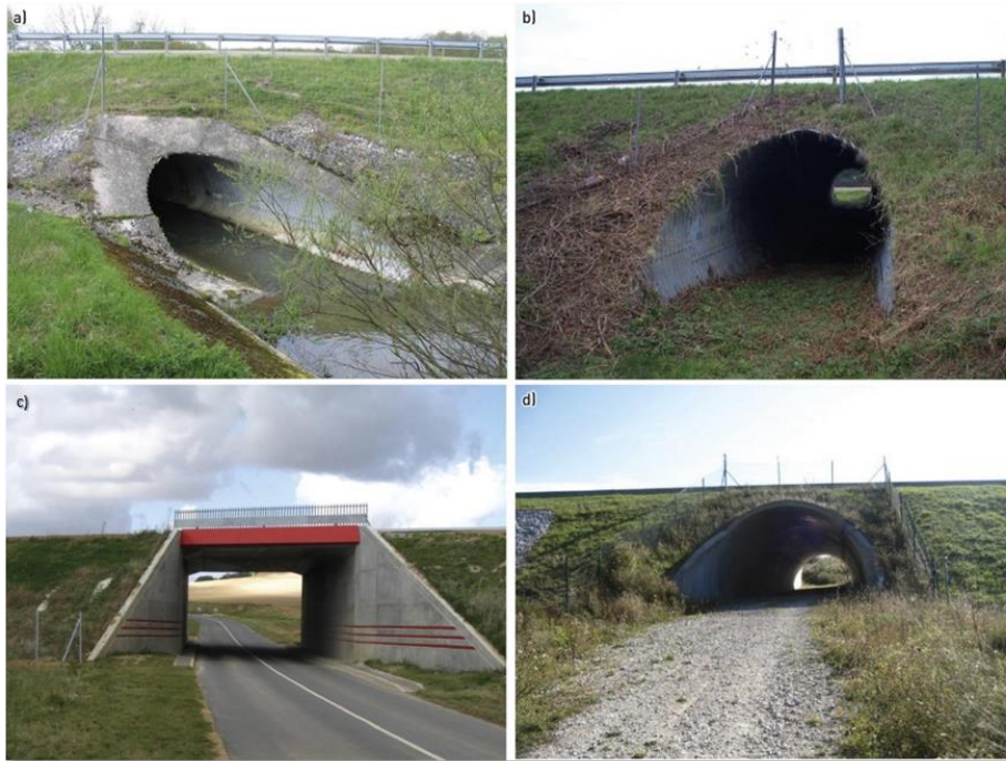
Figure 5.10. Exemples d’ouvrages de franchissement existants avec un potentiel variable d’amélioration de la connectivité (source : Sanef)
