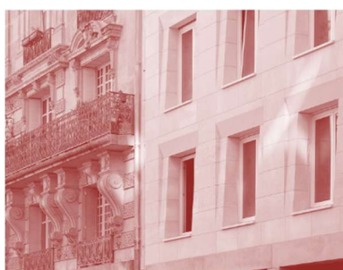
Fig. 210. Hausmann revisité par Barraud et Pressacco à Oberkampf. Le retour de stéréotomie dans les façades parisiennes et le maintien d'un principe tectonique pour les planchers.
