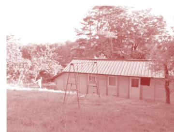
Fig. 370. Maisonnette de Flagy. Prolonger l'existence d'une construction légère qui n'avait sans doute pas prévue de vivre déjà aussi longtemps.
