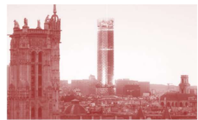
Fig. 134. La rénovation de la tour Montparnasse (image, nouvelle AOM)
