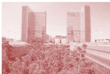
Fig. 273. La Bibliothèque François Mitterrand par Dominique Perrault.
