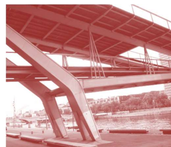
Fig. 528. Extrémité de la passerelle Simone de Beauvoir
