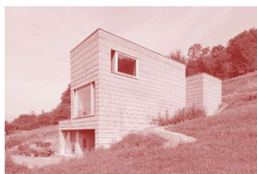
Fig. 386. Maison en terre par Martin Rauch
