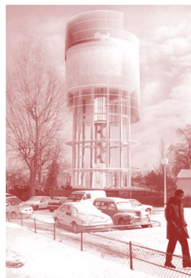
Fig. 196. Illustration du Château d'eau du quartier du Bel-Air à Montreuil, reconverti en pile thermique urbain.
