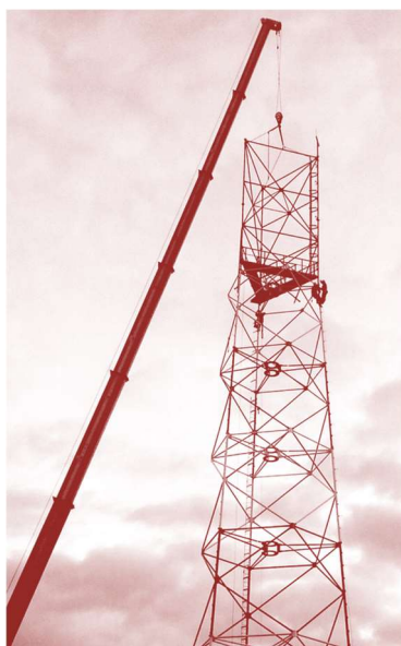
Fig. 568. Le prototype de Vitré en cours de construction, 2015 et avant le montage des 3 rotors.
