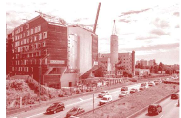
Fig. 312. Les bâtiments capteurs la Maison de l'Île-de-France à la Cité Internationale Universitaire de Paris, livrée en 2017 par l'agence Nicolas Michelin avec ses cuves de stockage inter-saisonnier.
