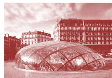
Fig. 355. Les pièces moulées en inox de la couverture de métro de la Gare Saint-Lazare (architecte, Arte-Charpentier ; ingénieurs, RFR). Projet suivi en réalisation au côté de Mitsu Edwards. Le « choc industriel » lors de la visite de l'usine d'extrusion des profilés en acier inoxydable (2002).
