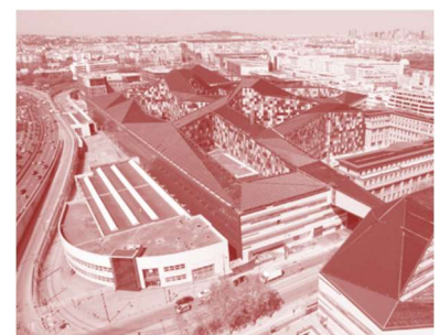
Fig. 229. Le projet Balard et le ministère des armées à proximité du périphérique parisien. 5600m 2 de toitures productives.
