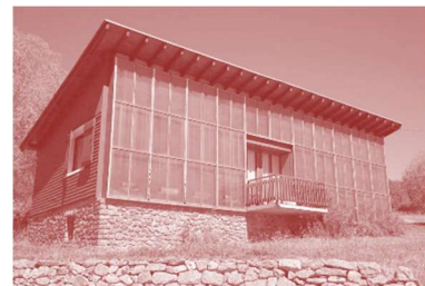
Fig. 316. La maison Tricaud avec ses murs Trombe-Michel.
