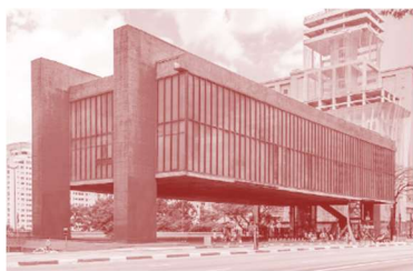
Fig. 271. Bo Bardi. Bo Bardi à Sao Paulo. Le MASP, inauguré en 1968, est suspendu à deux énormes portiques qui supportent une charge de 9 200 tonnes, il en résulte un espace libre de 74 mètres.
