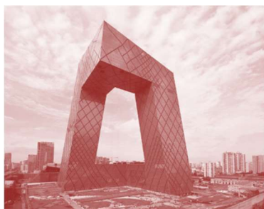
Fig. 272. CCTV à Pékin par OMA
