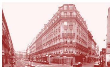
Fig. 207. Immeuble de rapport, rue de Châteaudun. Une coupe dans un immeuble haussmannien. [14]
