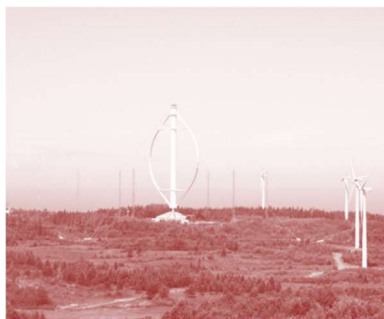
Fig. 128. Éolienne à axe vertical de type Darrius, à Cap Chat, au Québec. 110 m de haut et capacité de 4MW
