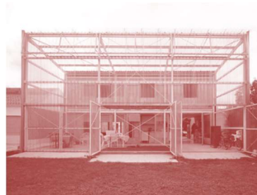
Fig. 278. Maison Latapie par Lacaton & Vassal.
