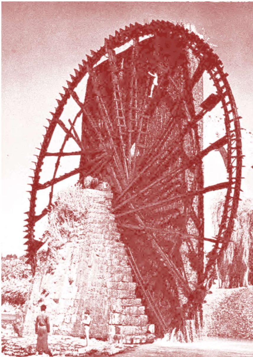
Fig. 136. Roue hydraulique syrienne de 64 pieds sur la rivière Orontes qui permettait d'assurer la livraison d'eau dans les maisons et jardins de Hama. D'après Rudolfsky [16].
