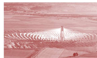
Fig. 214. Solucar, les centrales solaires thermodynamiques à tour, PS10 et PS20 (PS 10 sur la photo aérienne)
