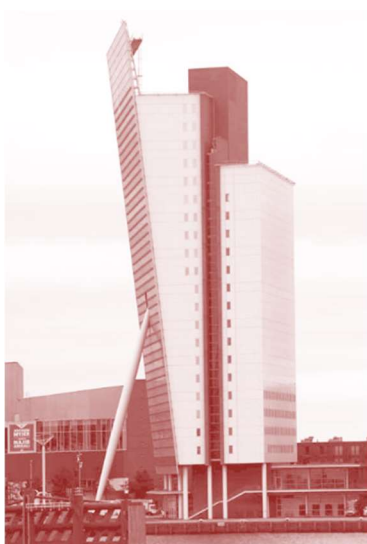
Fig. 358. Exprimer l'optimisation de la matière en compression et donner à voir le surplus nécessaire au milieu d'un poteau articulé. Un gimmick architectural à l'apogée du mouvement high-tech. Tour KPN à Rotterdam, RPBW
