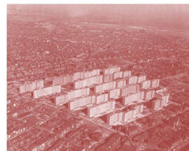
Fig. 77. Ensemble urbain, Pruitt-Igoe, dans le Missouri, par l'architecte Minoru Yamasaki
