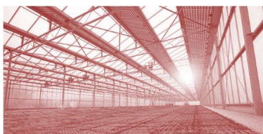
Fig. 240. Serre maraîchère avec intégration de panneaux photovoltaïques
