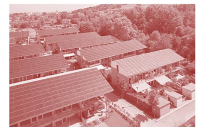
Fig. 236. Le Quartier Solaire au sein de l'écoquartier Vauban à Fribourg-Im-Brigsau et ses toits photovoltaïques
