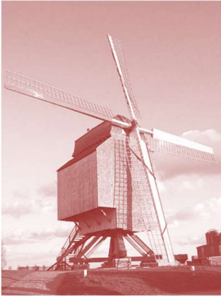
Fig. 441. Une éolienne en bois
