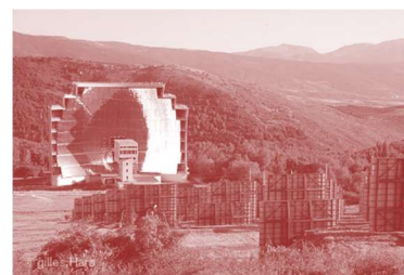
Fig. 215. Centrale solaire d'Odeillo
