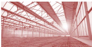
Fig. 240. Serre maraîchère avec intégration de panneaux photovoltaïques
