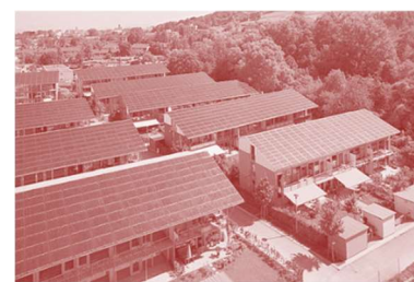
Fig. 236. Le Quartier Solaire au sein de l'écoquartier Vauban à Fribourg-Im-Brigsau et ses toits photovoltaïques
