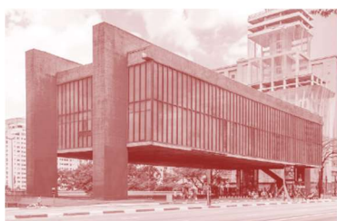
Fig. 271. Bo Bardi. Bo Bardi à Sao Paulo. Le MASP, inauguré en 1968, est suspendu à deux énormes portiques qui supportent une charge de 9 200 tonnes, il en résulte un espace libre de 74 mètres.
