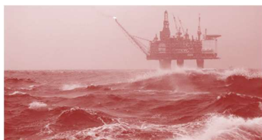
Fig. 303. Une plateforme pétrolière offshore.
