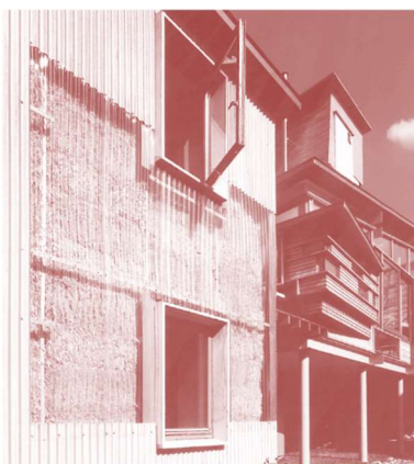
Fig. 385. Stock Orchard Street par l'architecte Sarah Wigglesworth. Isolation en paille. Londres, 2001
