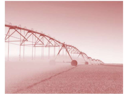
Fig. 351. Rampes frontales pour l'agriculture. Un bel exemple d'économie de matière pour une grande portée et la recherche d'un coût minimum.
