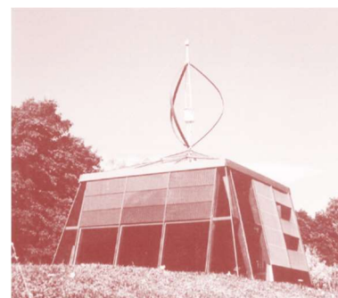
Fig. 308. La maison d'Alexander Pike et le foisonnement du solaire passif, du solaire thermique et de l'éolien.
