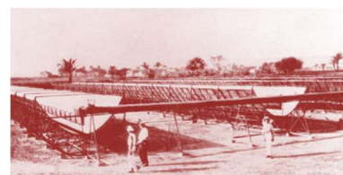
Fig. 213. L'une des premières centrales héliothermodynamiques avec des miroirs paraboliques. Centrale à focalisation linéaire à Meadi en Egypte, 1913 par l'Américain F. Shuman.
