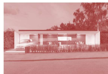
Fig. 328. La maison B10 de Sobek et sa voiture électrique associée.
