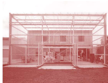
Fig. 278. Maison Latapie par Lacaton & Vassal.
