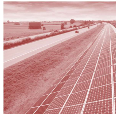
Fig. 228. Solarisation d'une autoroute en Allemagne, à proximité de Munich. Un écran photovoltaïque producteur utilisé également comme barrière acoustique.
