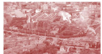
Fig. 342. Boues rouges associées à la production de bauxite, en amont de la production de l'aluminium. Usine d'Altéo, en pleine ville de Gardanne, au nord de Marseille, à l'origine des pollutions par boues rouges.
