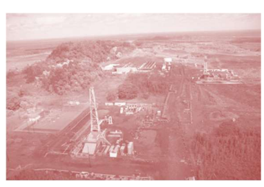
Fig. 178. Centrale géothermique de Puna, Big Island, Hawaï, États-Unis.
