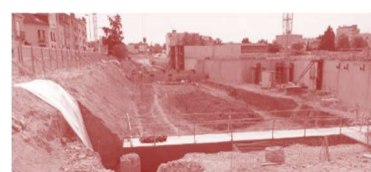
Fig. 179. Photos de terrassements et d'installation des carneaux d'un tronçon de puits canadiens sur le campus Artem à Nancy (photos Elioth, 2010). En bas, la galerie Artem finie, avec le diffuseur de puits canadien visible en second plan.
