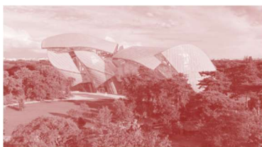
Fig. 268. Fondation LVMH par Frank Gehry, près de 15 tonnes par m 2 utile.
