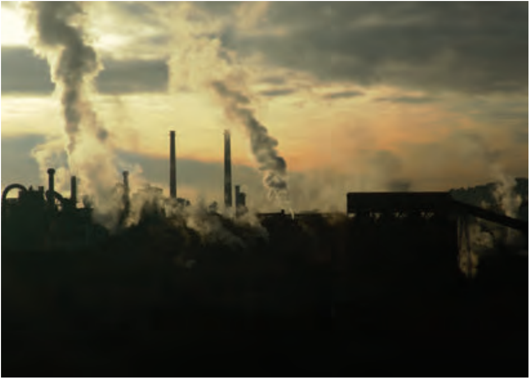
122 • Usine d'alumine de Gardanne [janvier 2016]
