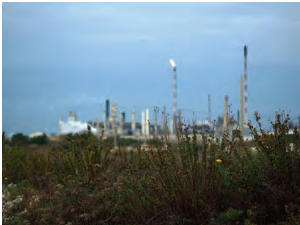
167 • Plage de Ponteau, raffinerie de Lavéra, Martigues [janvier 2016].
