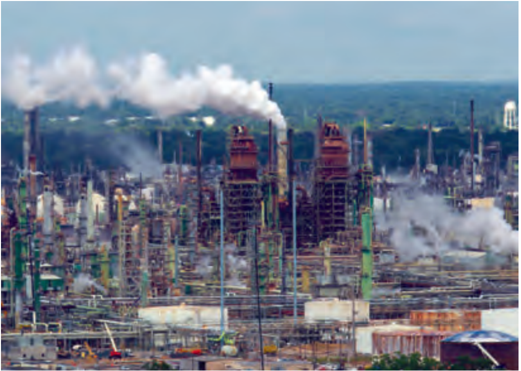
120 • Raffinerie Exxon de Baton Rouge, Louisiane [août 2015].
