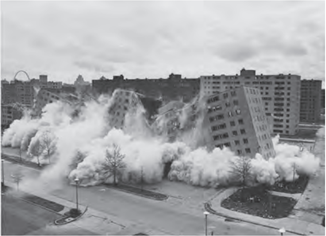
56 • Démolition de Pruitt-Igoe, le 15 juillet 1972 [U.S. Department of Housing and Urban Development].
