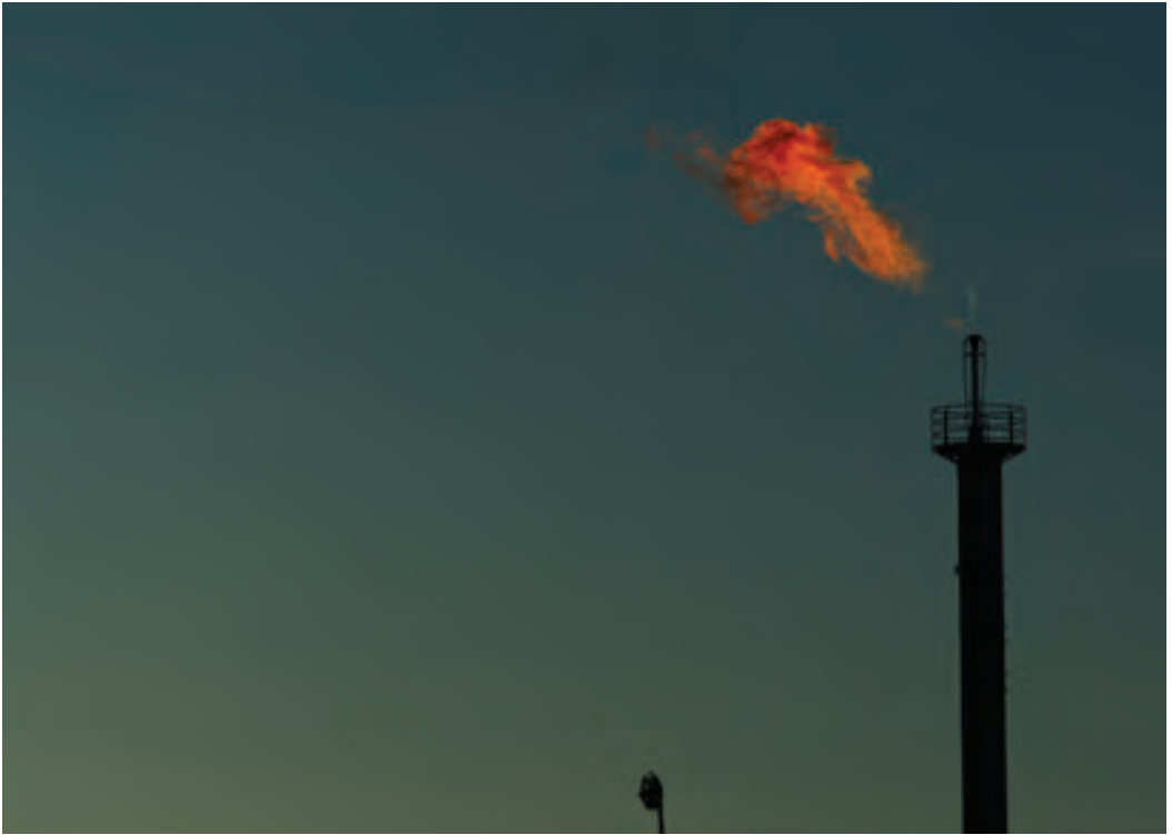
124 • Torchère de Géogaz, Fos-sur-Mer [février 2016].
