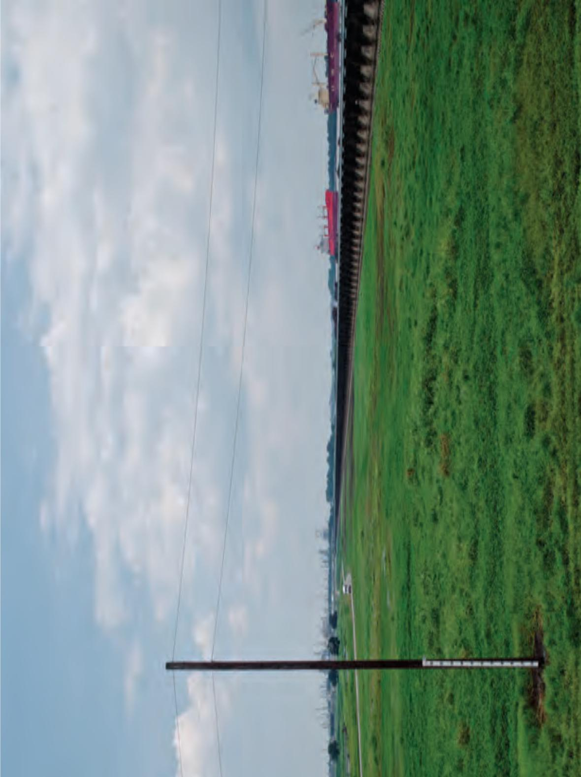
152 • Terminée en 1931, après la grande crue de 1927, Bonnet Carré Spillway est un barrage filtrant de plus de deux kilomètres de long qui agit comme une soupape réduisant la quantité d'eau du Mississippi en la canalisant dans le lac Pontchartrain [août 2015].
