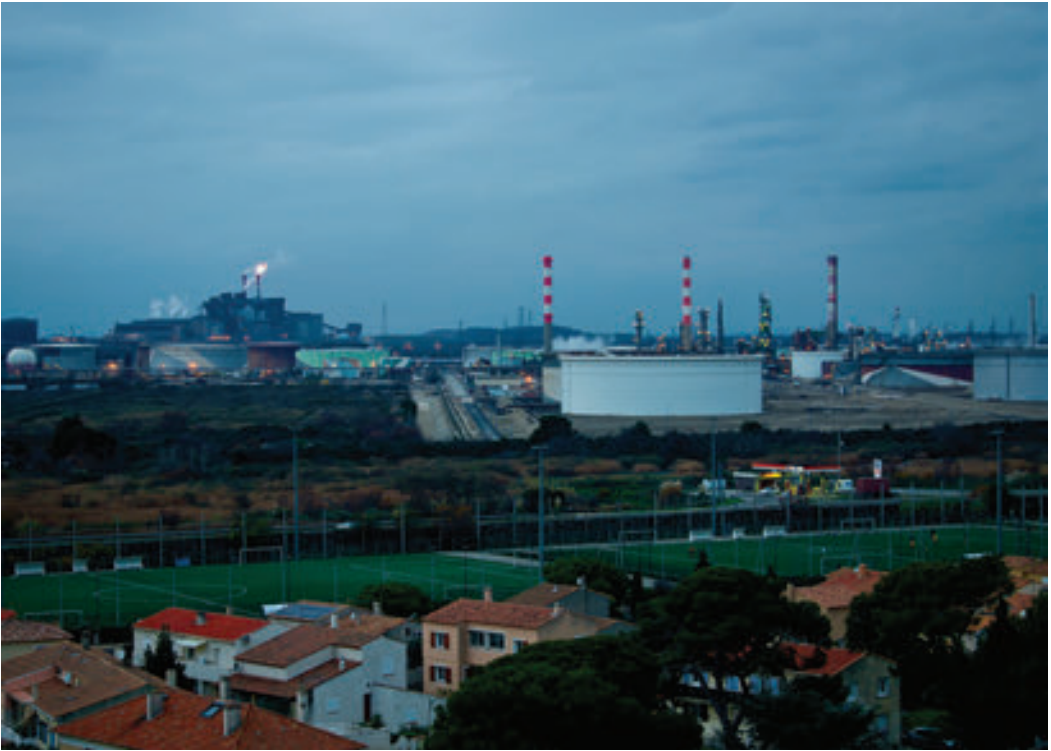
125 • Raffinerie Esso et aciérie ArcelorMittal, Fos-sur-Mer [janvier 2016].
