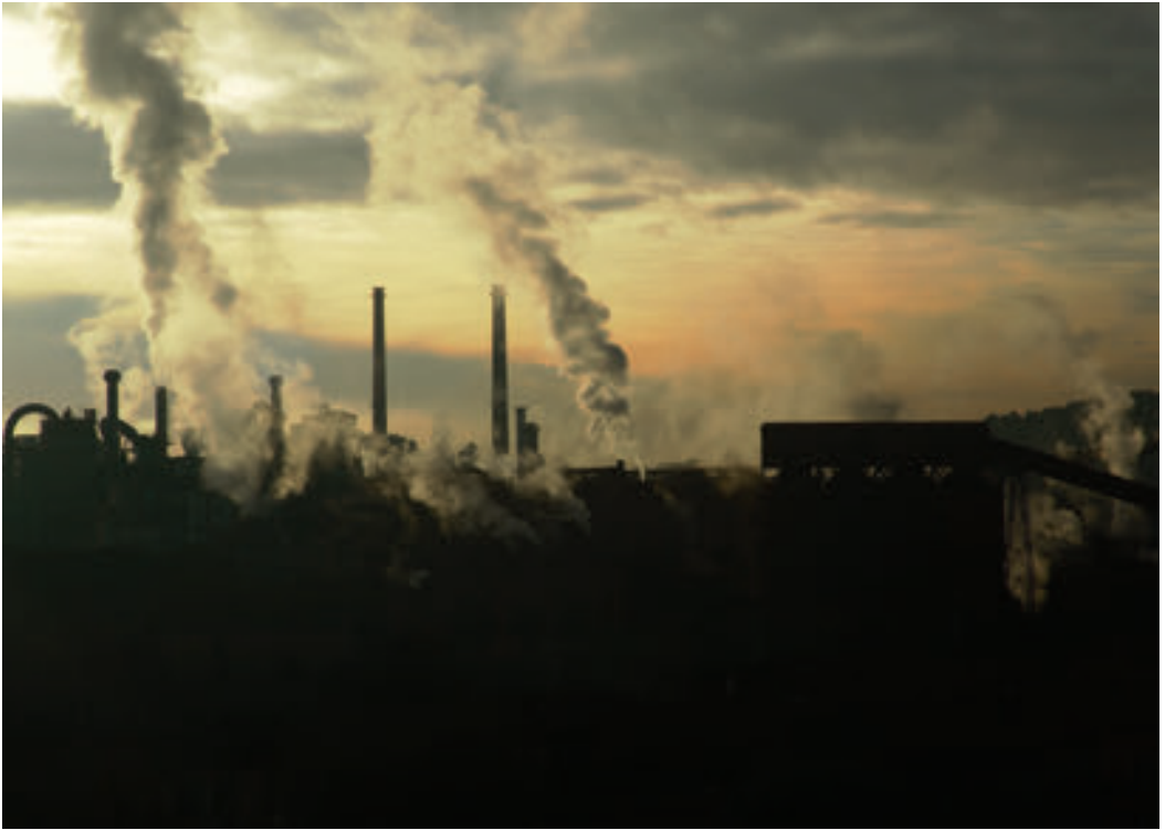
122 • Usine d'alumine de Gardanne [janvier 2016]
