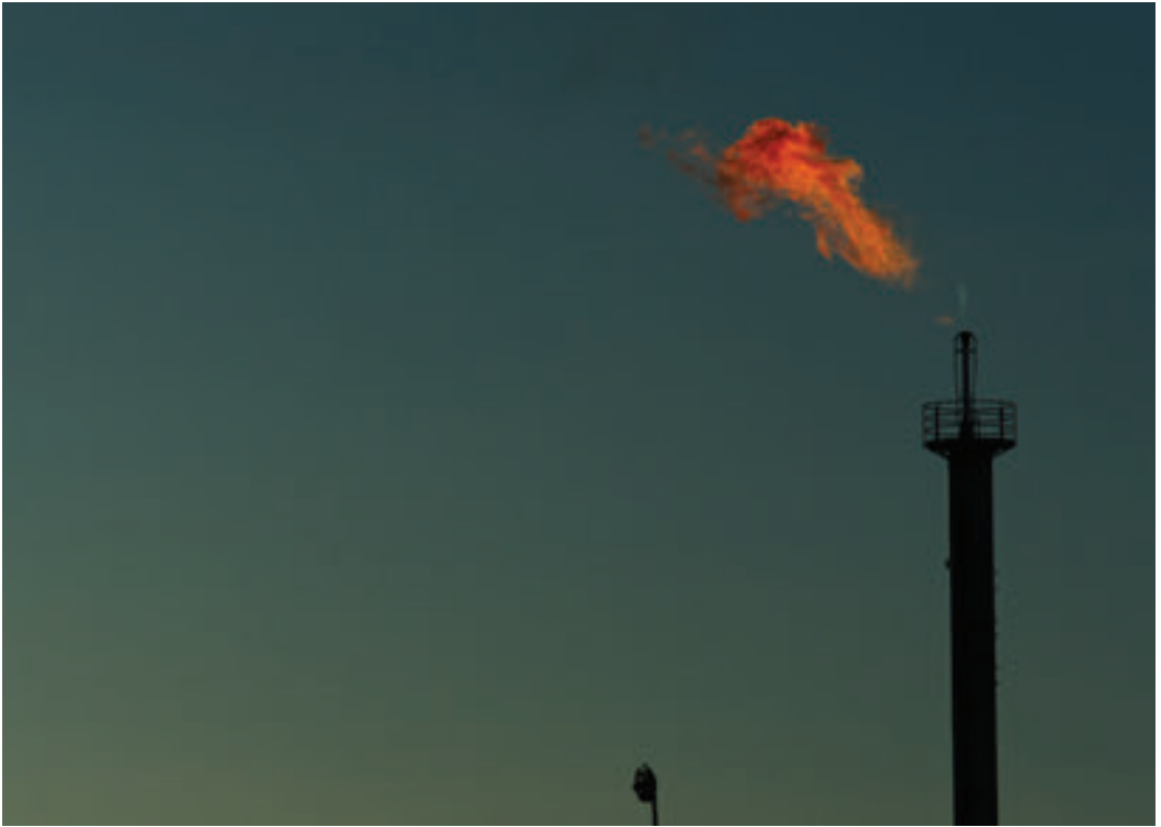
124 • Torchère de Géogaz, Fos-sur-Mer [février 2016].
