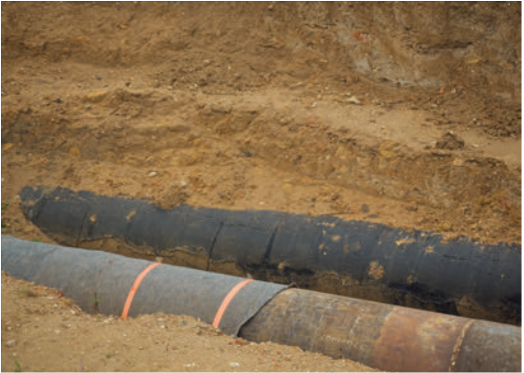
129 • Contrôle de corrosion sur le pipeline de pétrole de la Société du Pipeline Méditerranée-Rhône [février 2018].
