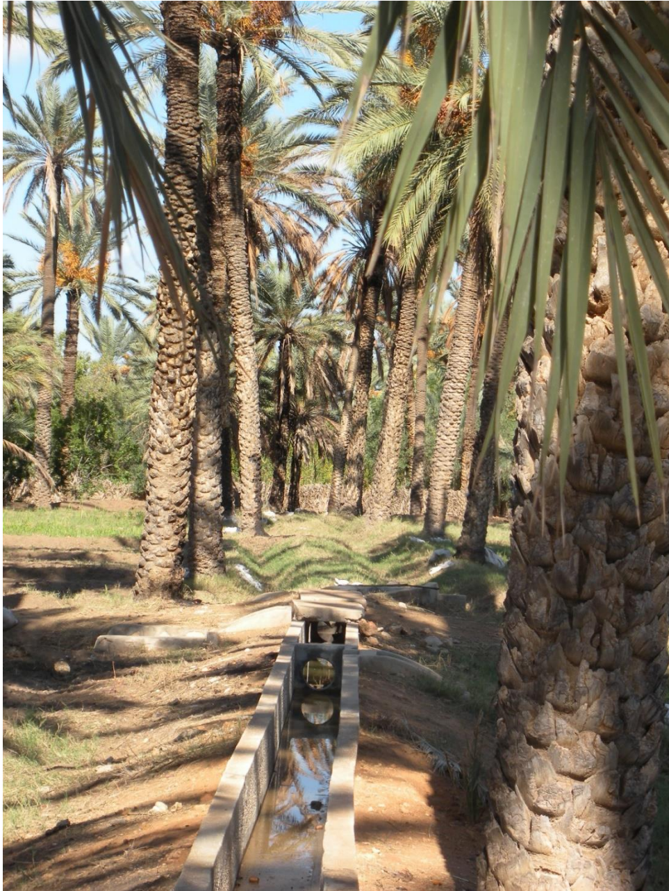
Figure 20: Séquia bétonnée à Gabès, dans la zone de Chenini
