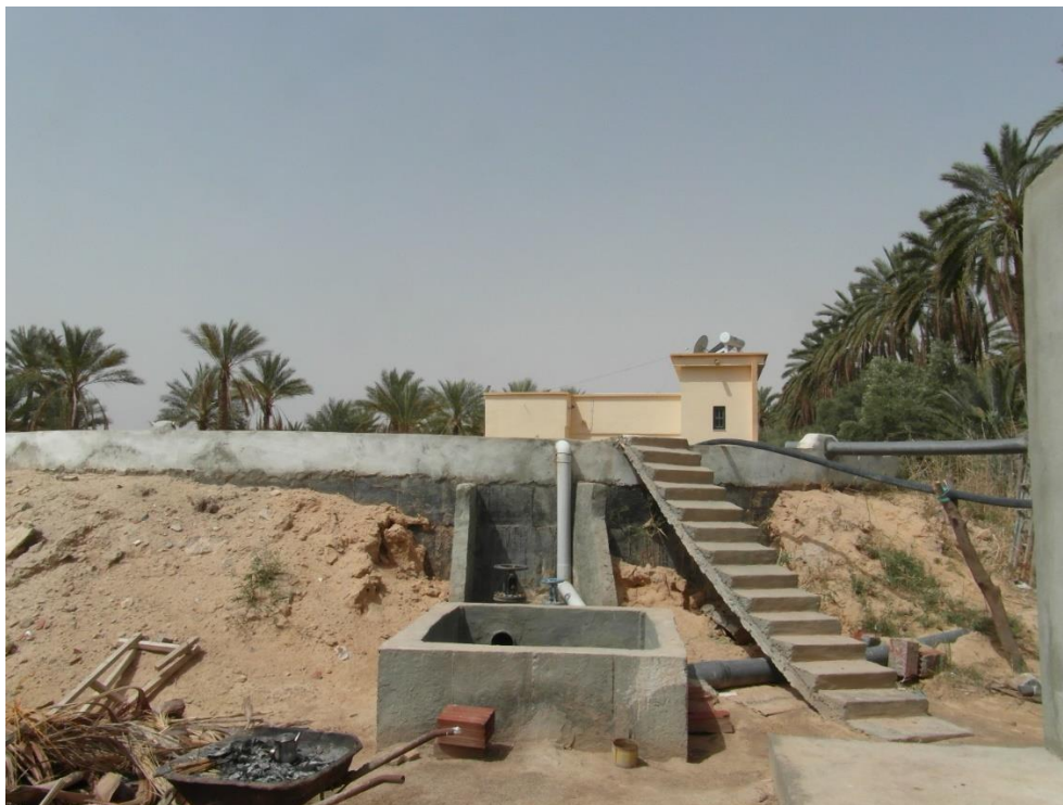
Figure 69. Forage et bassin dans une parcelle de Tozeur, 2013
