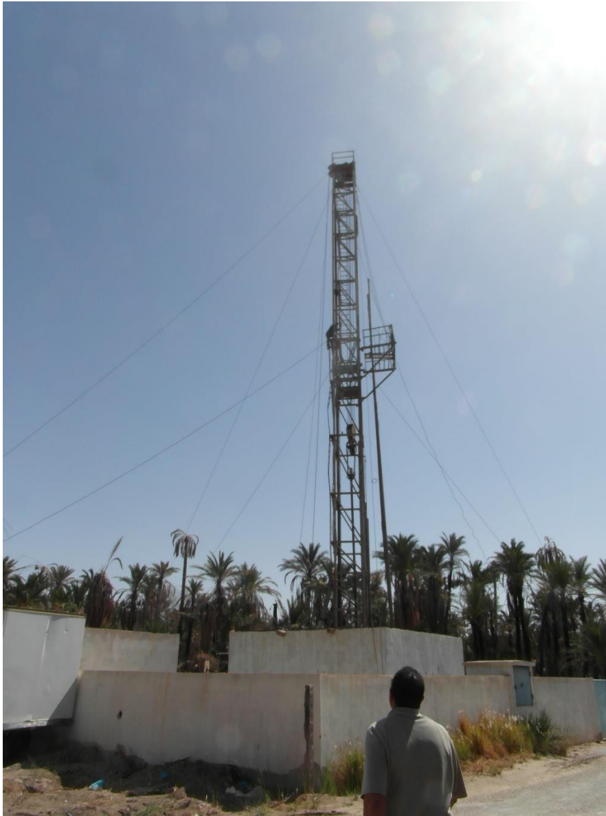
Figure 36: Forage en panne de l'oasis de Tozeur, 2014
