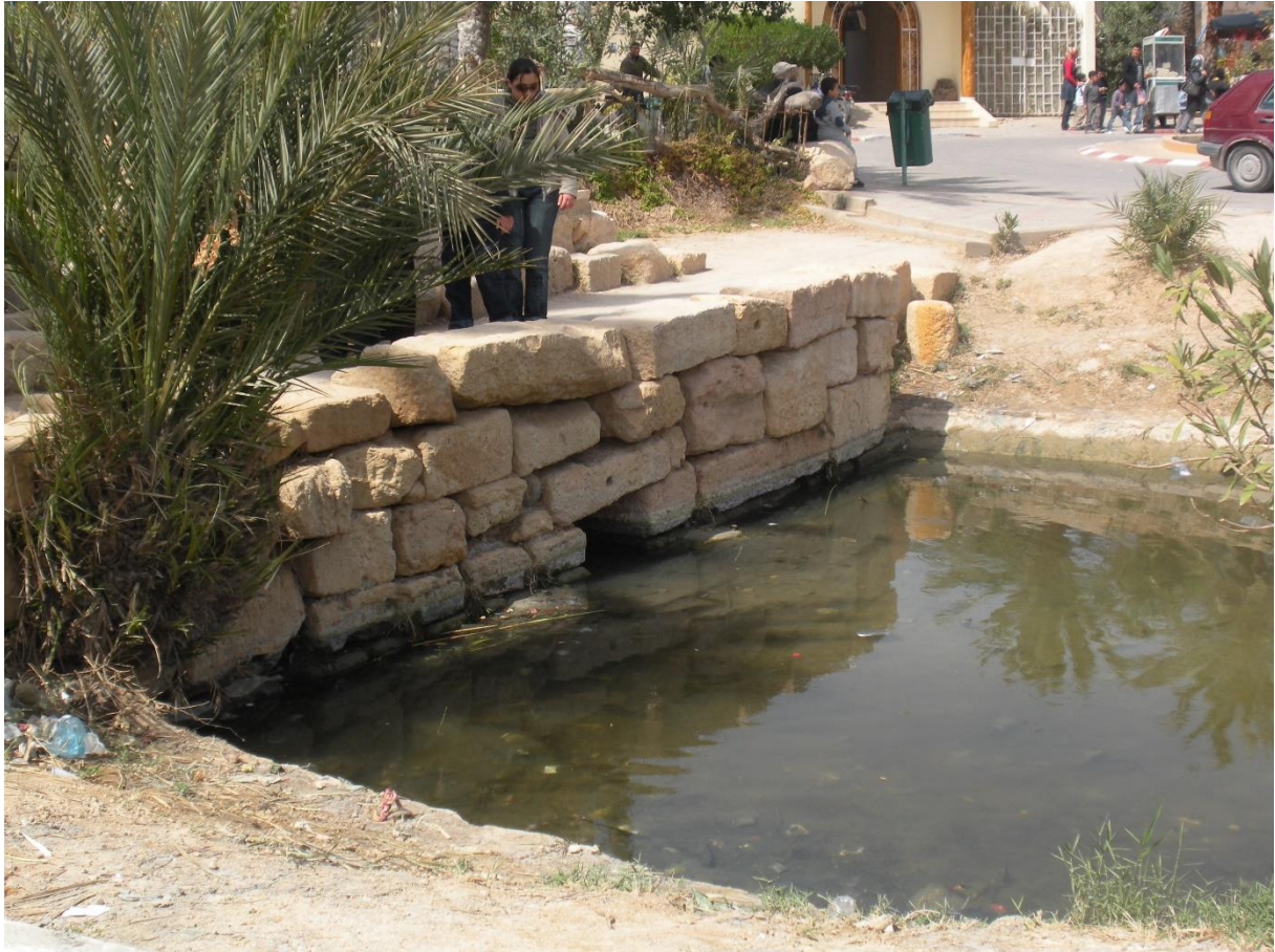
Figure 13: Le barrage romain "Sed Reha" à Chenini Gabès, 2012
